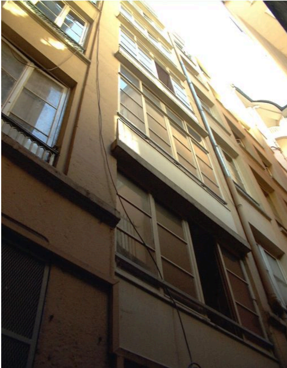
Vue de la cage d'escaliers sur cour
