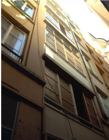
Vue de la cage d'escaliers sur cour Phot. Maryannick Chalabi IVR82_20016900920NUCA
