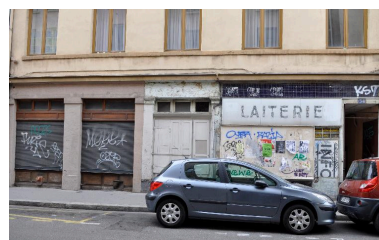
Détail du rez-de-chaussée : vestiges de pilastres ; devanture ; ancienne laiterie Phot. Magali Delavenne IVR84_20166900784NUCA
