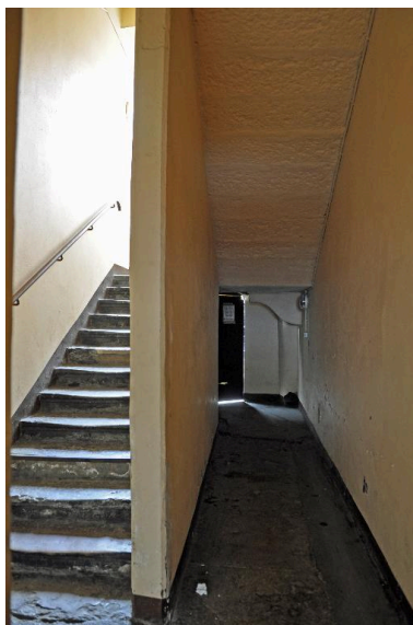
Vue intérieure : le départ de l'escalier rampe-sur-rampe Phot. Magali Delavenne IVR84_20166900786NUCA
