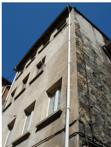
Façade arrière Phot. Isabelle Dupuis IVR82_20123800171NUCA
