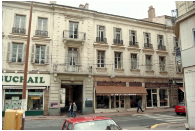
Façade principale (partie droite), rue Gambetta Phot. Cendrine Sanquer IVR82_19974201868ZE
