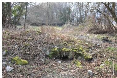
Passage du canal voûté visible dans l'un des murs du bâtiment. Phot. Clara Bérelle IVR84_20187300177NUCA
