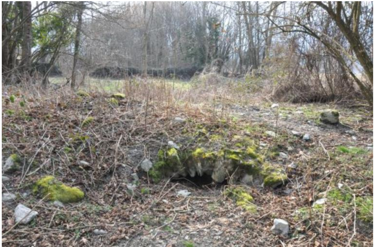
Passage du canal voûté visible dans l'un des murs du bâtiment.
