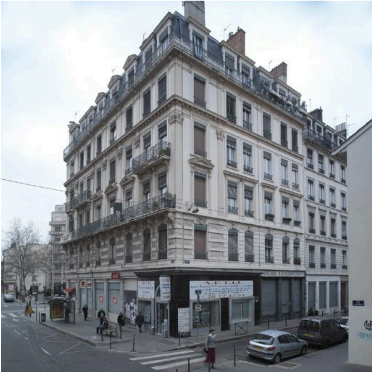
Vue d'ensemble depuis la grande rue de la Guillotière
