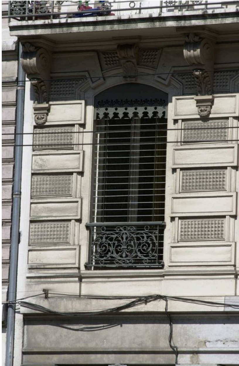
Détail d'une fenêtre de l'entresol, avenue Jean-Jaurès
