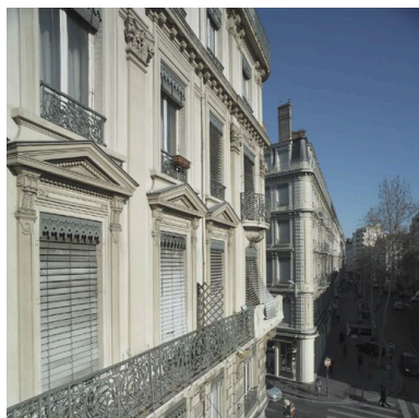
Détail du 1er étage, avenue Jean-Jaurès Phot. Eric Dessert IVR82_20046904041NUCA
