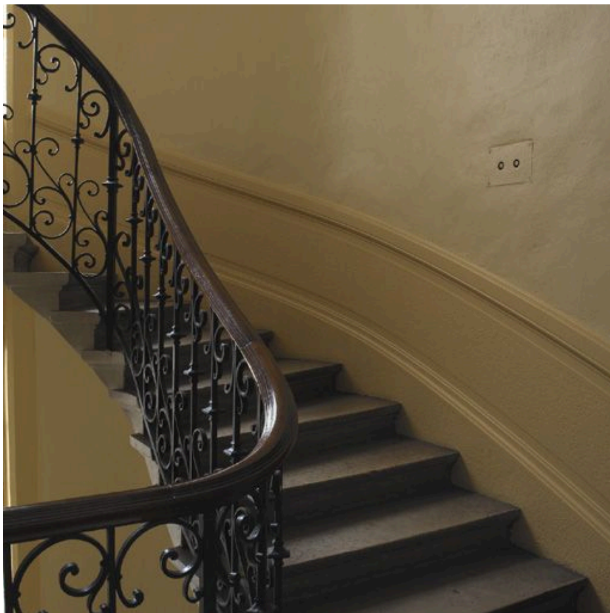
Vue de l'escalier
