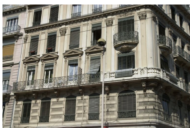
Détail du décor de façade avenue Jean-Jaurès Phot. Coralie Belleville IVR82_20026902929NUCA
