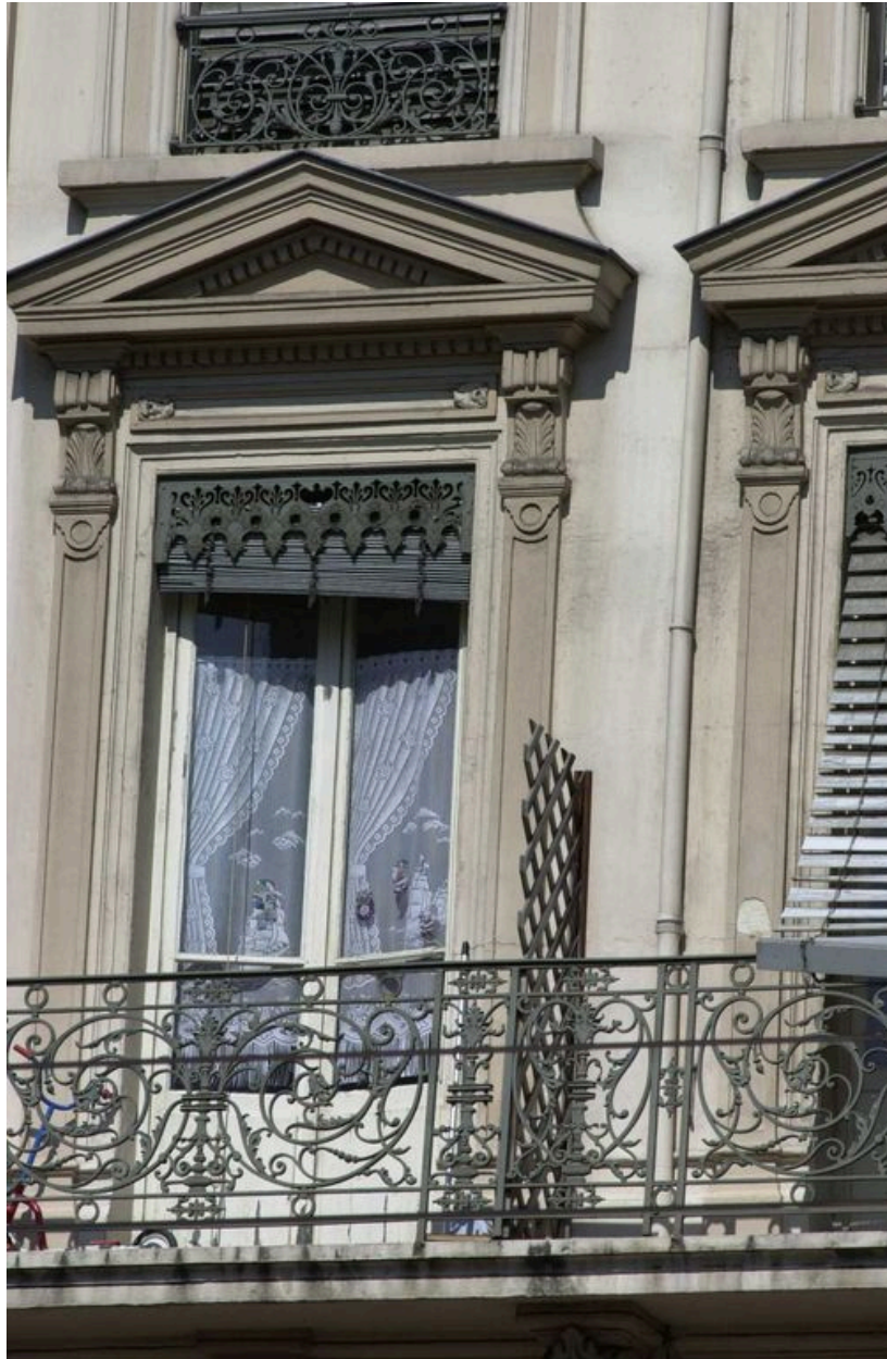
Détail d'une fenêtre du 1er étage avenue Jean-Jaurès
