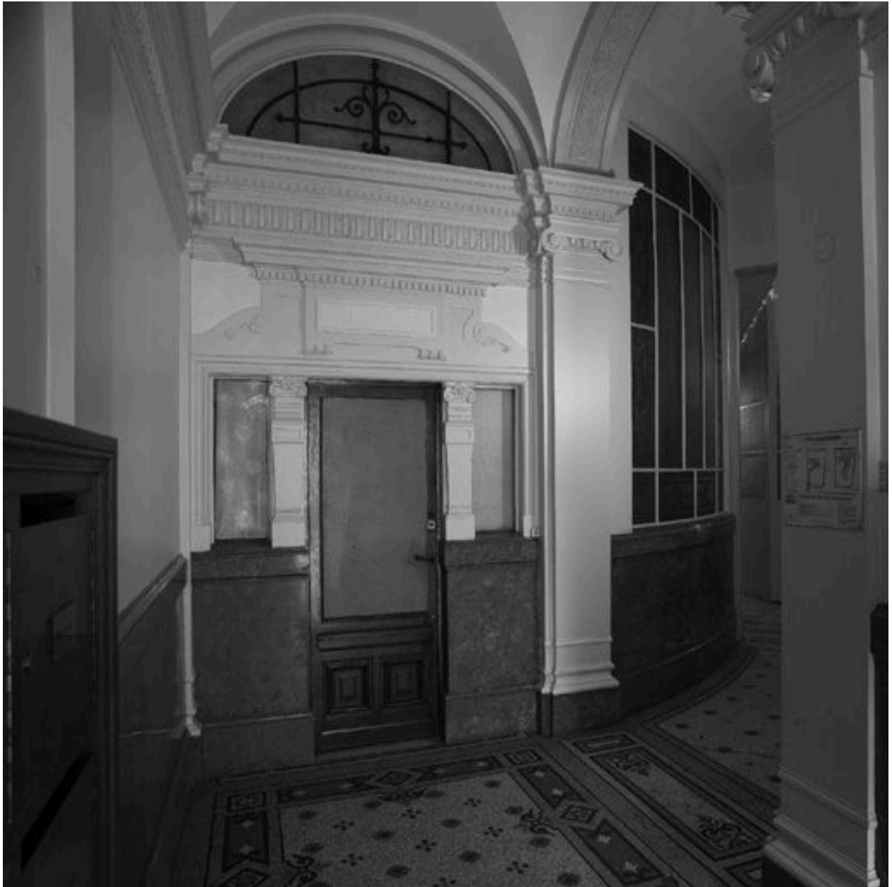
Vue d'ensemble de la loge de concierge et du couloir menant à l'escalier
