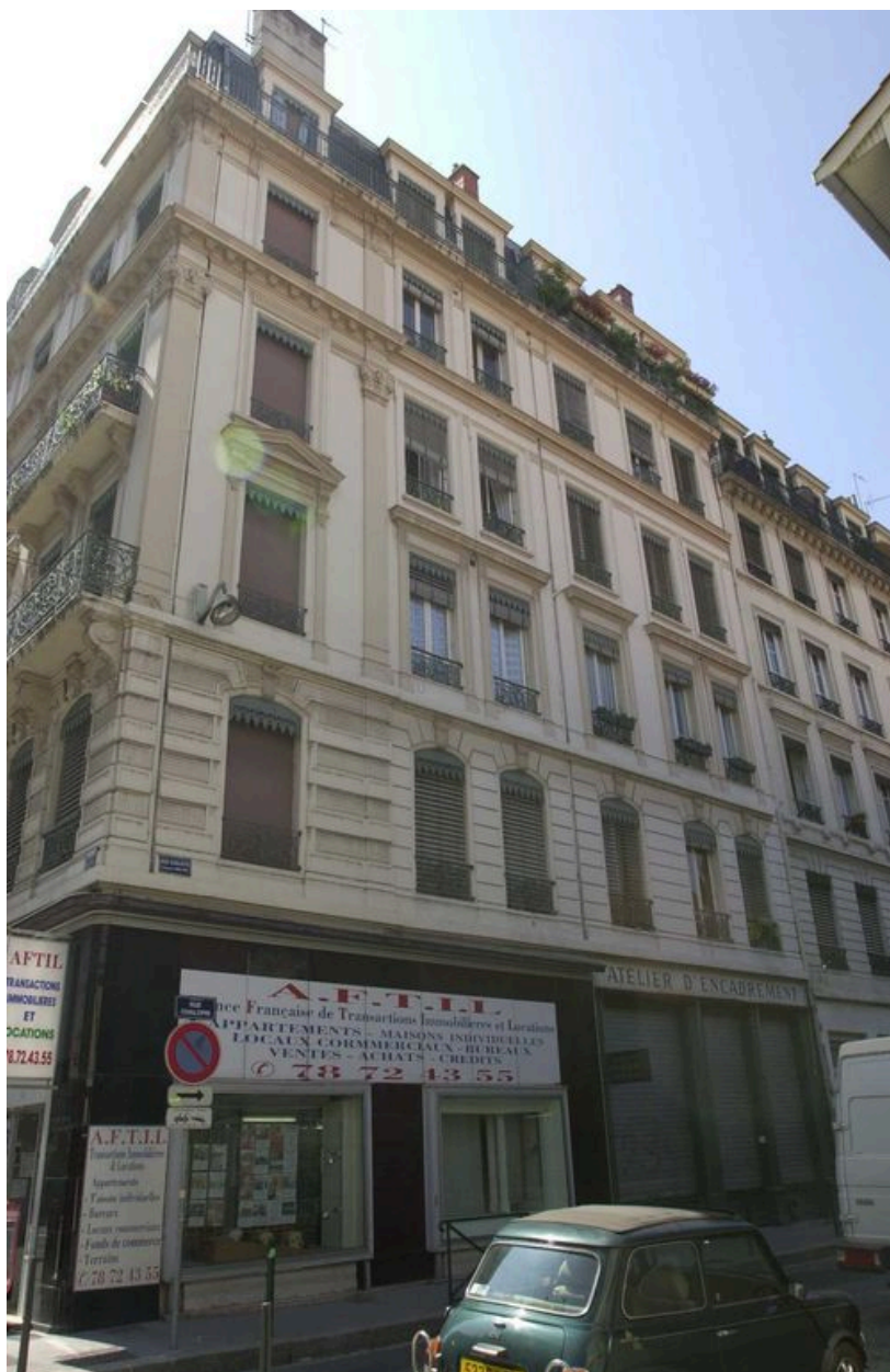
Vue d'ensemble de la façade rue Chalopin
