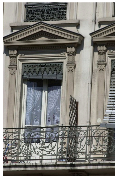
Détail d'une fenêtre du 1er étage avenue Jean-Jaurès
