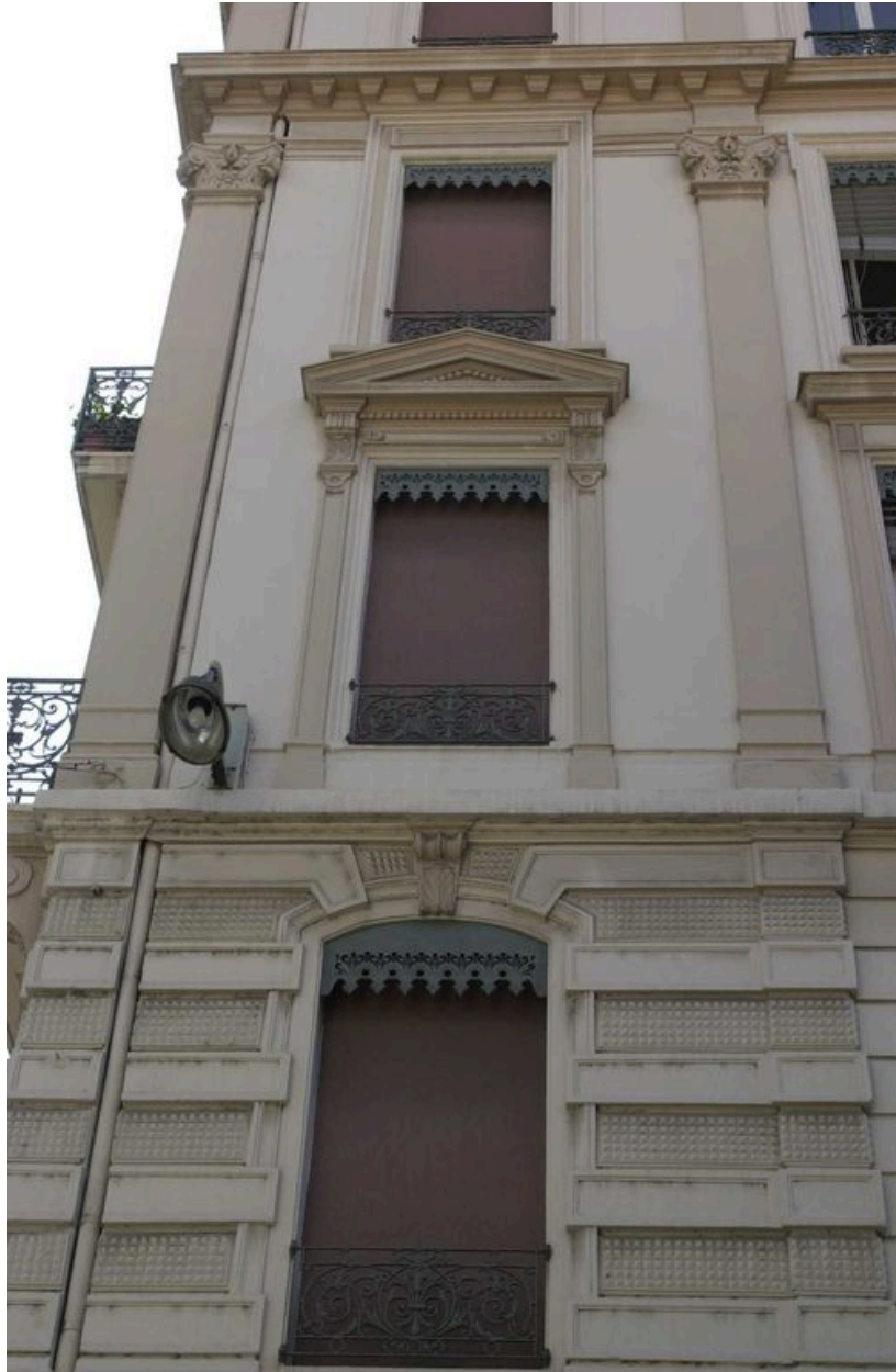
1 ère travée (murée), rue Chalopin
