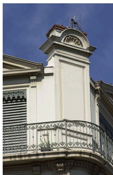
Cheminée d'angle Phot. Coralie Belleville IVR82_20026902933NUCA
