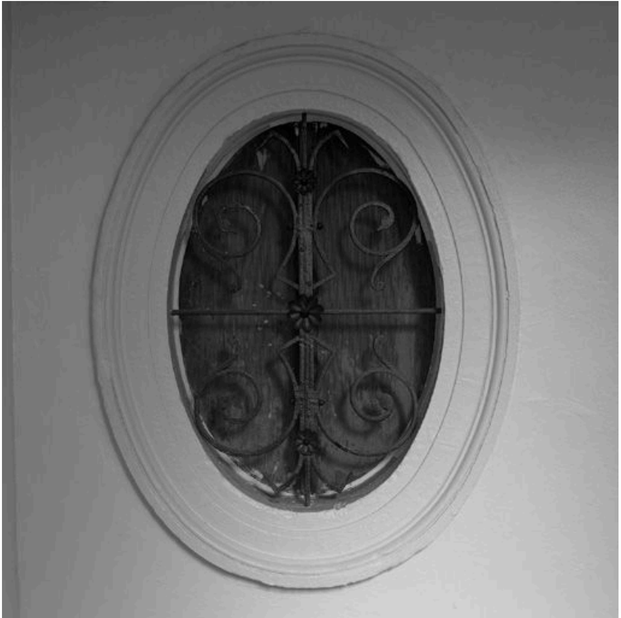
Détail de l'oculus ouvrant sur l'escalier, au rez-de-chaussée
