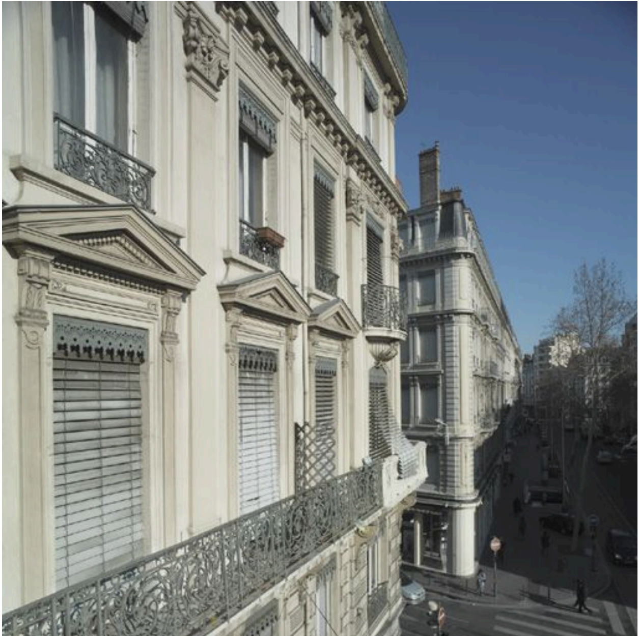
Détail du 1er étage, avenue Jean-Jaurès
