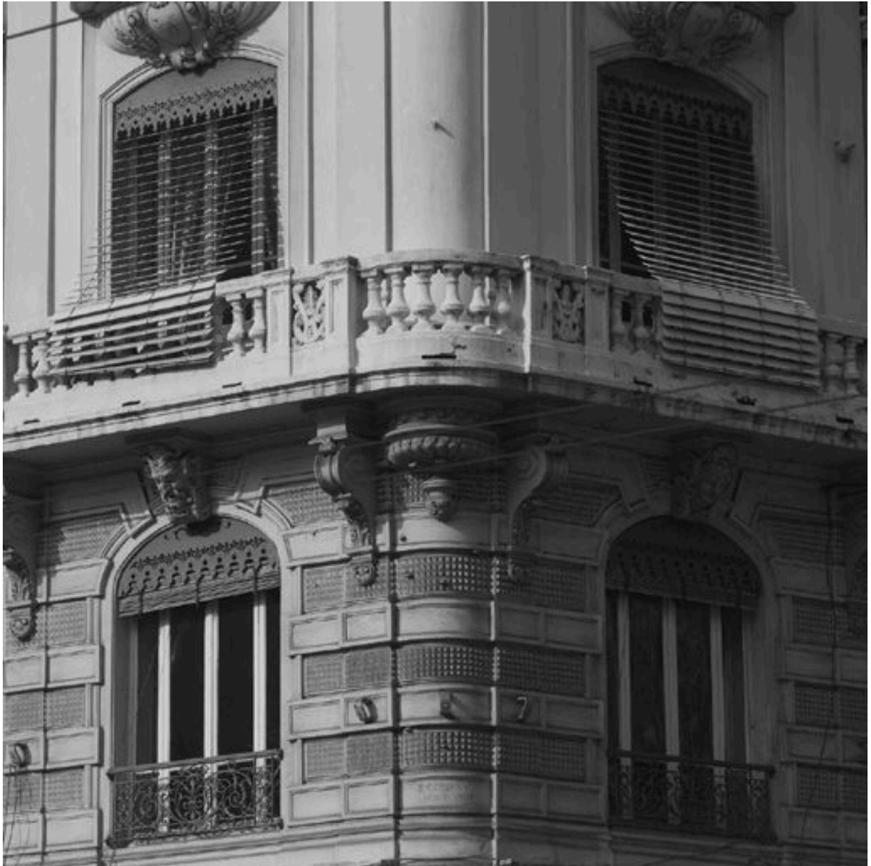
Détail de l'angle de l'immeuble, avenue Jean-Jaurès - grande rue de la Guillotière
