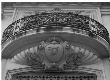
Détail du cul-de-lampe supportant le balcon arrondi, grande rue de la Guillotière Phot. Eric Dessert IVR82_20046904466NUC
