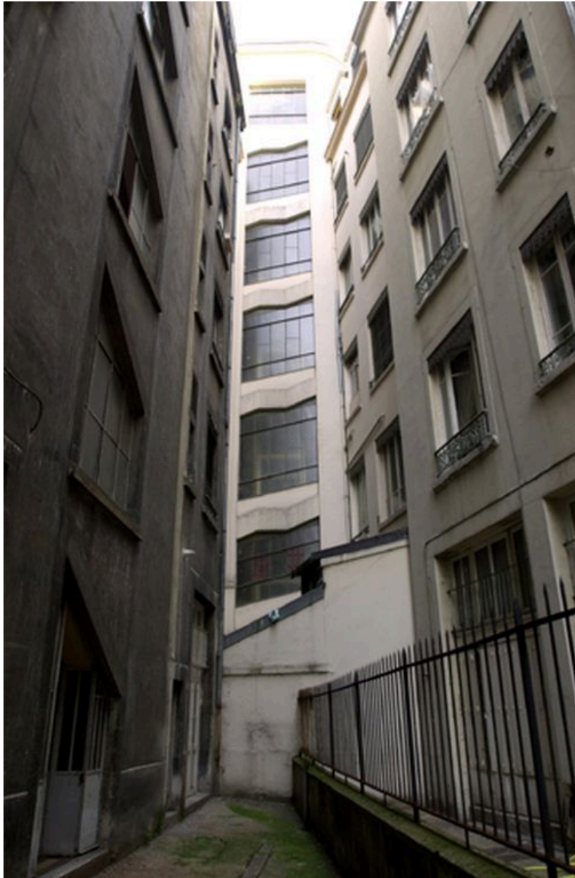
Elévation postérieure, vue de la travée d'escalier
