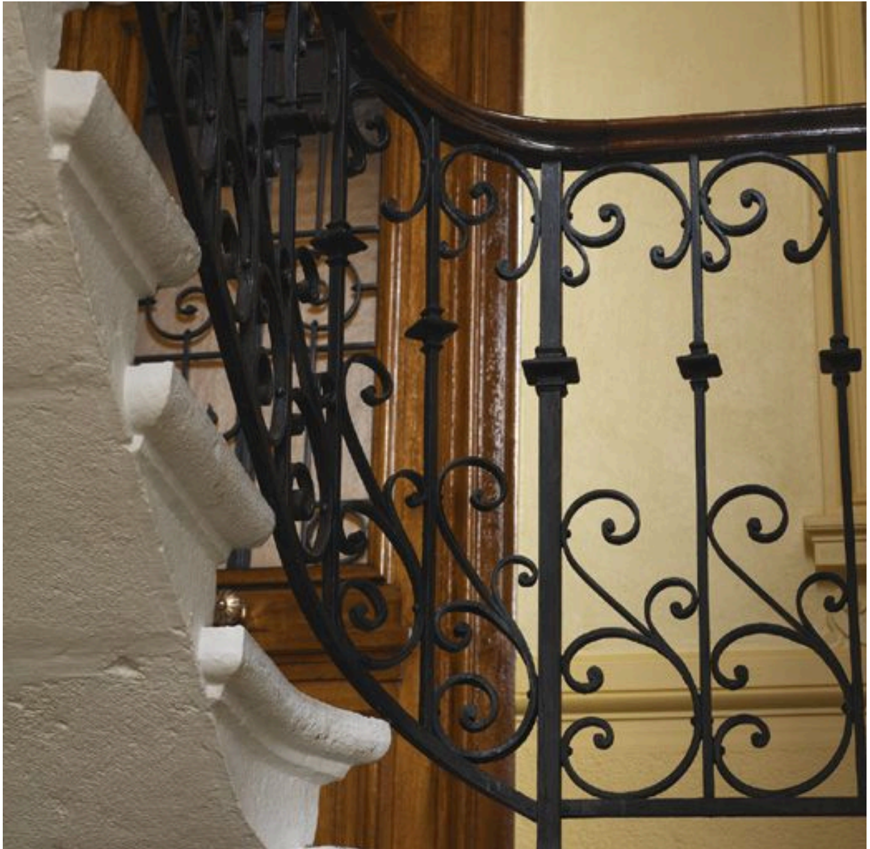
Détail de la rampe d'escalier
