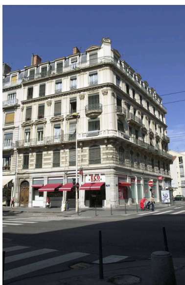
Façade, avenue Jean-Jaurès Phot. Coralie Belleville IVR82_20026902924NUCA
