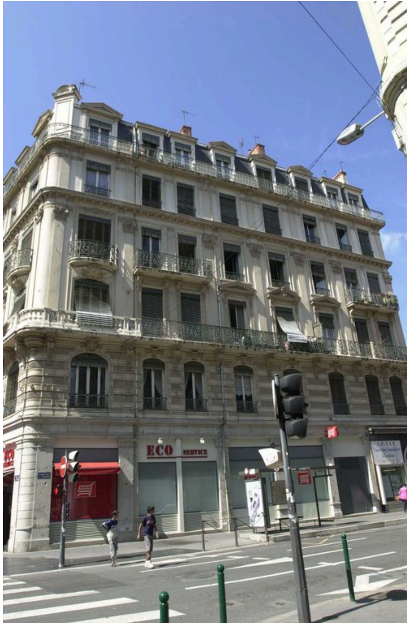
Vue d'ensemble de la façade grande rue de la Guillotière
