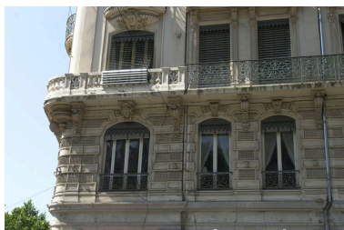
Détail de l'entresol, grande rue de la Guillotière Phot. Coralie Belleville IVR82_20026902935NUCA
