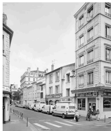
Vue des derniers étages, rue Chalopin, depuis le nord-ouest Phot. Didier Gourbin IVR82_20066902154V
