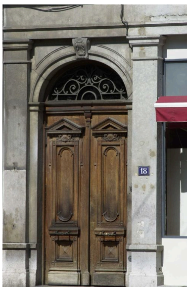
Détail de la porte d'entrée sur l'avenue Jean-Jaurès Phot. Coralie Belleville IVR82_20026902928NUCA
