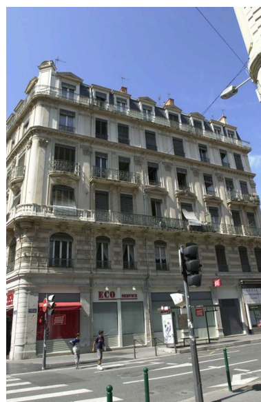
Vue d'ensemble de la façade grande rue de la Guillotière Phot. Coralie Belleville
