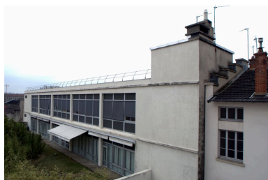
Elévation postérieure, niveaux supérieurs et terrasse Phot. Maryannick Chalabi IVR82_20116904057NUCA
