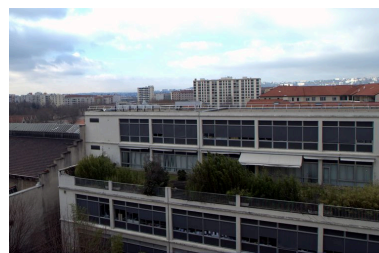
Elévation postérieure, vue partielle Phot. Maryannick Chalabi IVR82_20116904056NUCA
