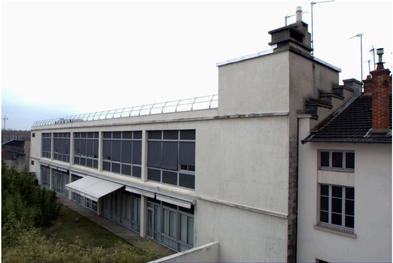
Elévation postérieure, niveaux supérieurs et terrasse
