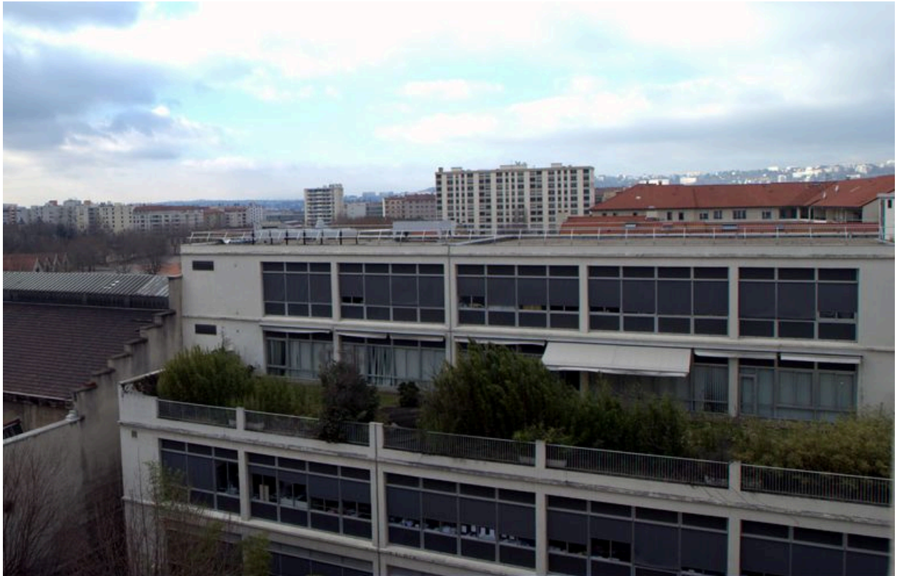
Elévation postérieure, vue partielle
