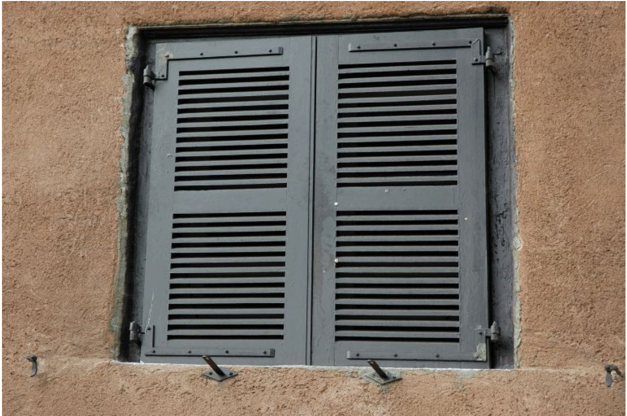
Détail, fenêtre à encadrement de bois sur l'élévation rue Bourgneuf.
