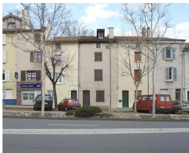
Vue de situation depuis le boulevard (2e maison à partir de la gauche). Phot. Eric Dessert IVR82_20064200284NUCA
