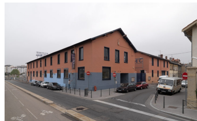
Vue générale sud-est Phot. Eric Dessert IVR82_20096905626NUCA
