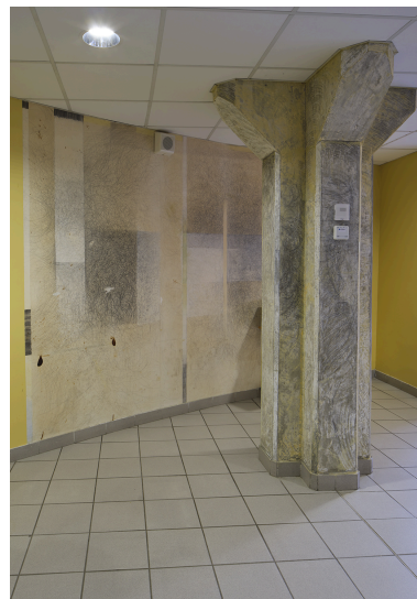
Détail : mur et pilier Phot. Michel Pérès, Phot. Franck Trabouillet IVR84_20220700275NUCA
