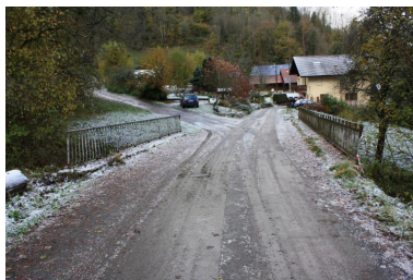
Le vieux pont de Trélachaud, contexte, chaussée et garde corps Phot. Benoît Huraut IVR84_20207401476NUCA
