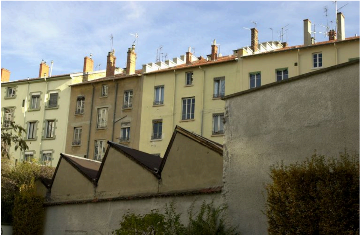
Détail des pignons découverts
