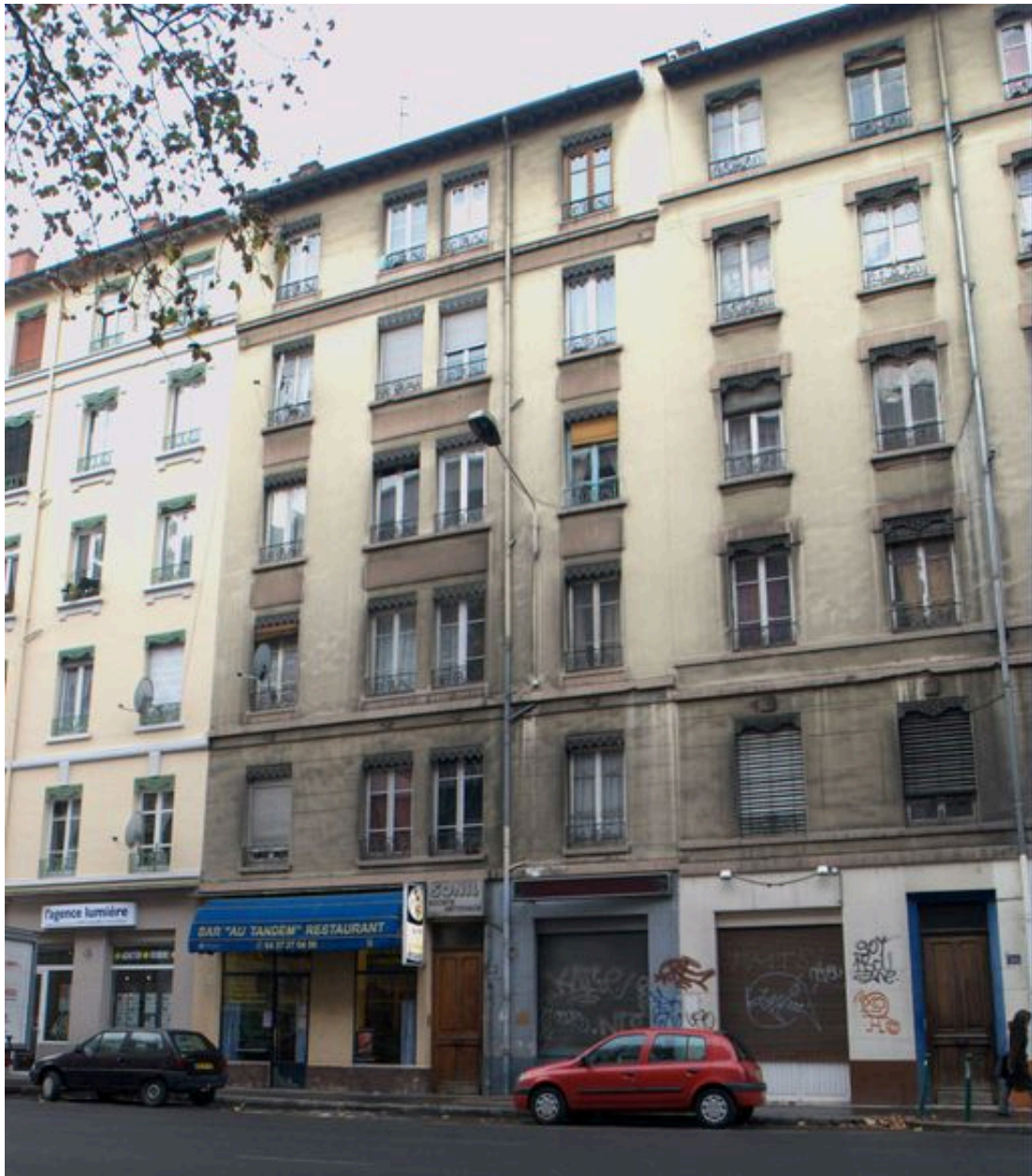
Elévation principale depuis le nord-est
