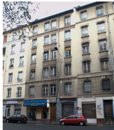
Elévation principale depuis le nord-est Phot. Maryannick Chalabi IVR82_20086900718NUCA
