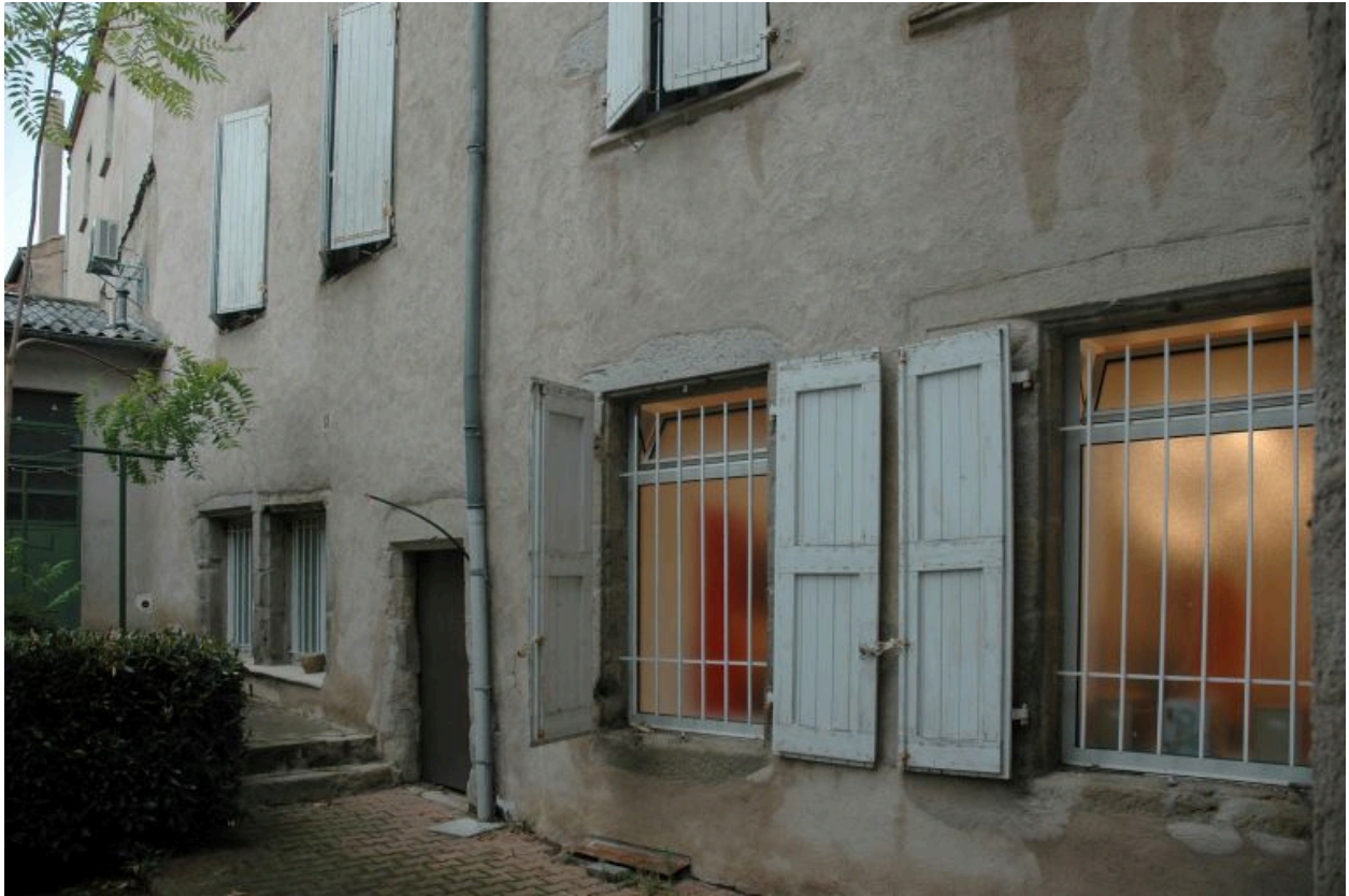
Vue partielle du rez-de-chaussée sur cour. Au fond : fenêtre jumelée et porte piétonne avec encadrements en cavet.
