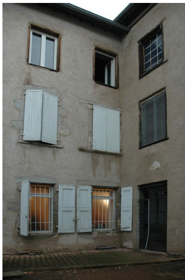
Elévations sur cour : revers de l'escalier demi-hors-oeuvre et logements sur cour. Phot. Simone Hartmann-Nussbaum IVR82_20124202787NUCA
