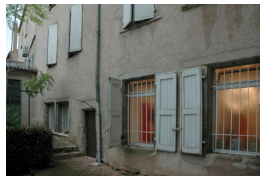
Vue partielle du rez-de-chaussée sur cour. Au fond : fenêtre jumelée et porte piétonne avec encadrements en cavet. Phot. Simone Hartmann-Nussbaum IVR82_20124202789NUCA
