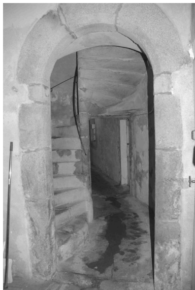
Vestibule menant à l'escalier en vis et aux habitations sur cour. Vue depuis la cour en direction de la rue. Phot. Simone Hartmann-Nussbaum IVR82_20124202786NUC
