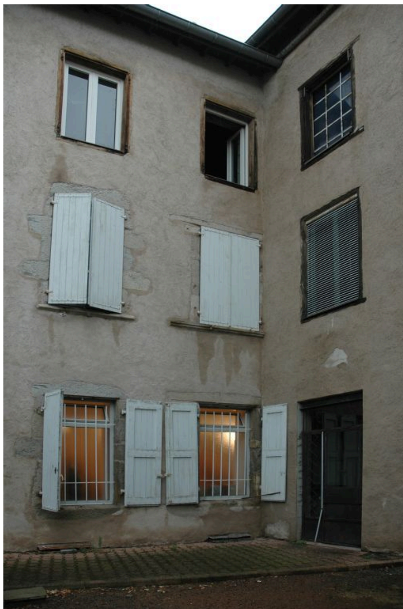
Elévations sur cour : revers de l'escalier demi-hors-oeuvre et logements sur cour.
