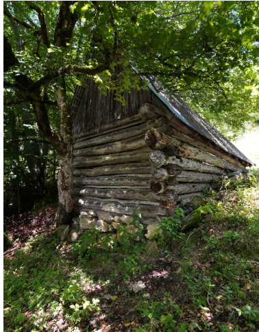
Vue d'ensemble côté aval. Phot. Thierry Leroy IVR84_20167401519NUCAQ
