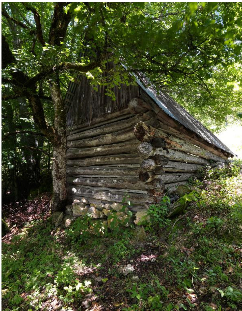
Vue d'ensemble côté aval.
