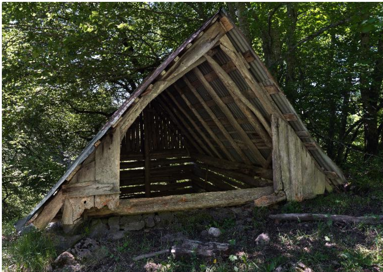
Vue d'ensemble côté amont.
