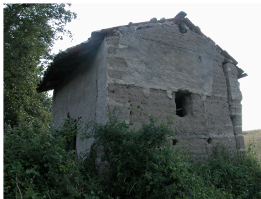
Vue d'ensemble. Phot. Thierry Monnet IVR82_20134200831NUCA
