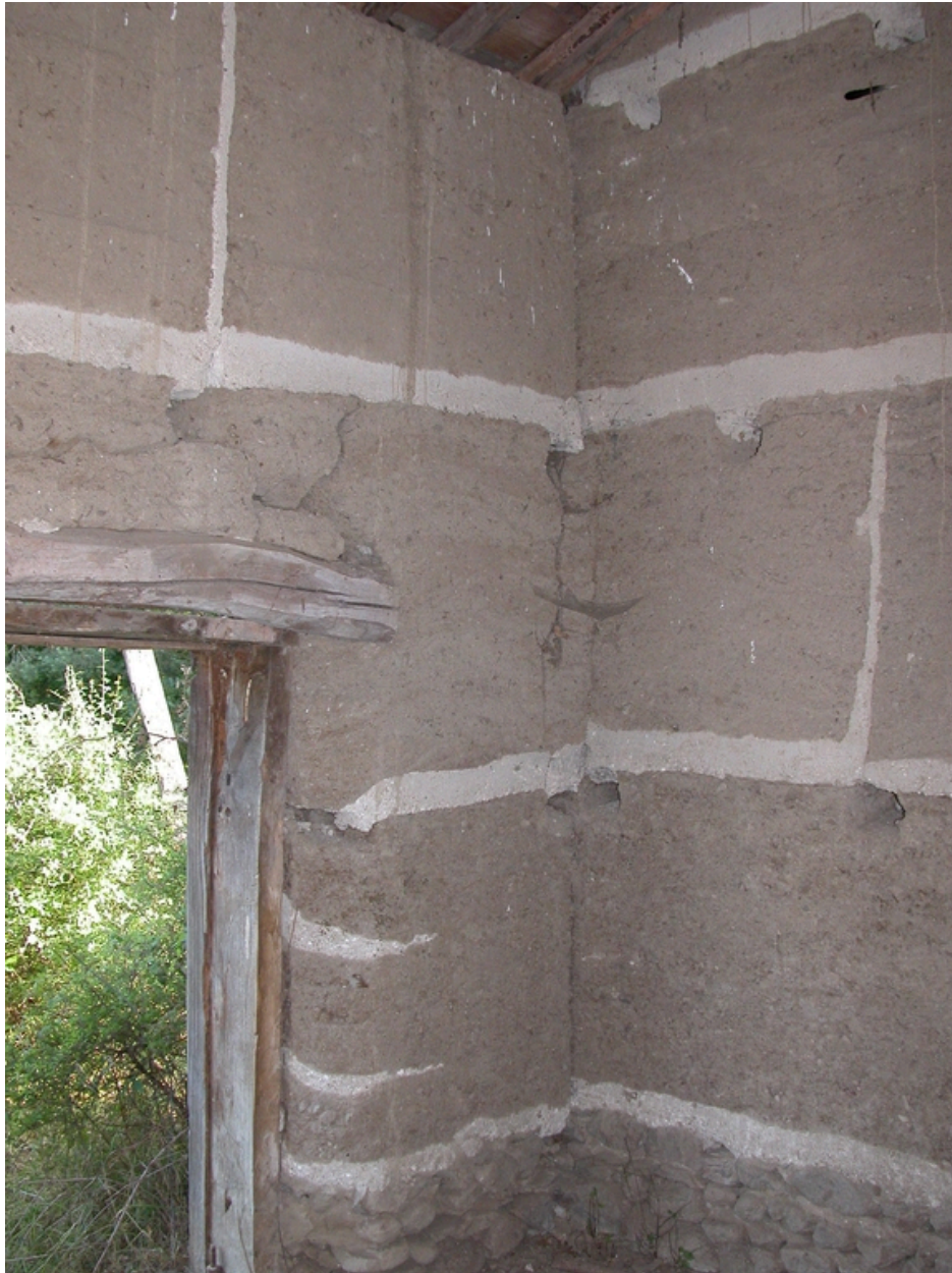
Vue intérieure : détail du pisé.
