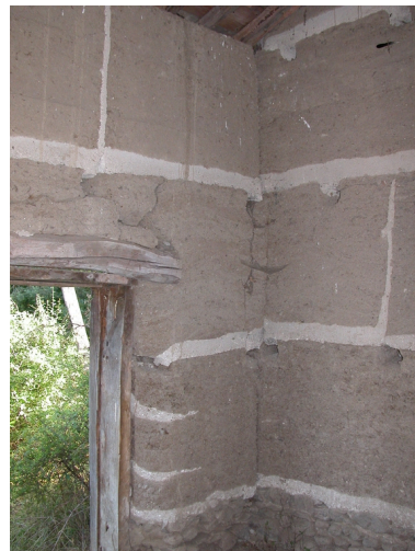
Vue intérieure : détail du pisé. Phot. Thierry Monnet IVR82_20134200830NUCA
