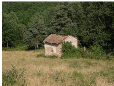
Vue générale Phot. Thierry Monnet IVR82_20134200829NUCA
