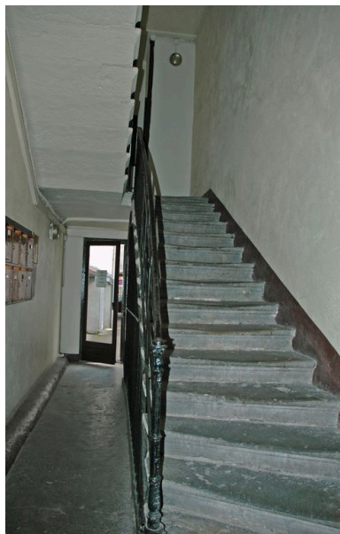
Première volée en pierre de la cage d'escalier vue depuis l'est Phot. Maryannick Chalabi IVR82_20066901391NUCA
