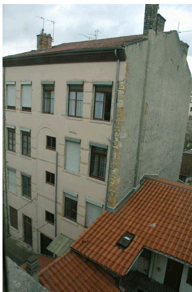
Façade ouest sur cour vue depuis une cage d'escalier au située nord Phot. Maryannick Chalabi IVR82_20066901392NUCA
