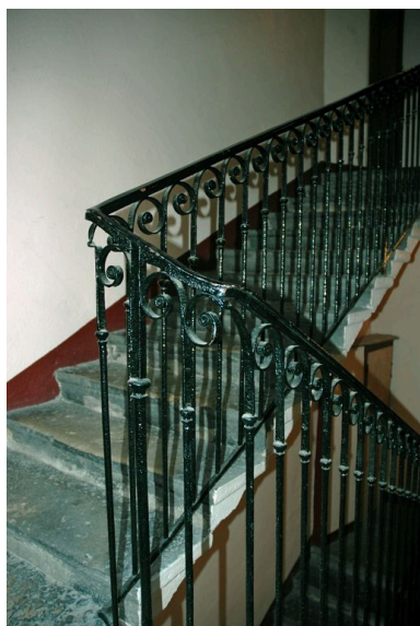
Volées d'escalier en pierre, vue depuis le repos Phot. Maryannick Chalabi IVR82_20066901297NUCA
