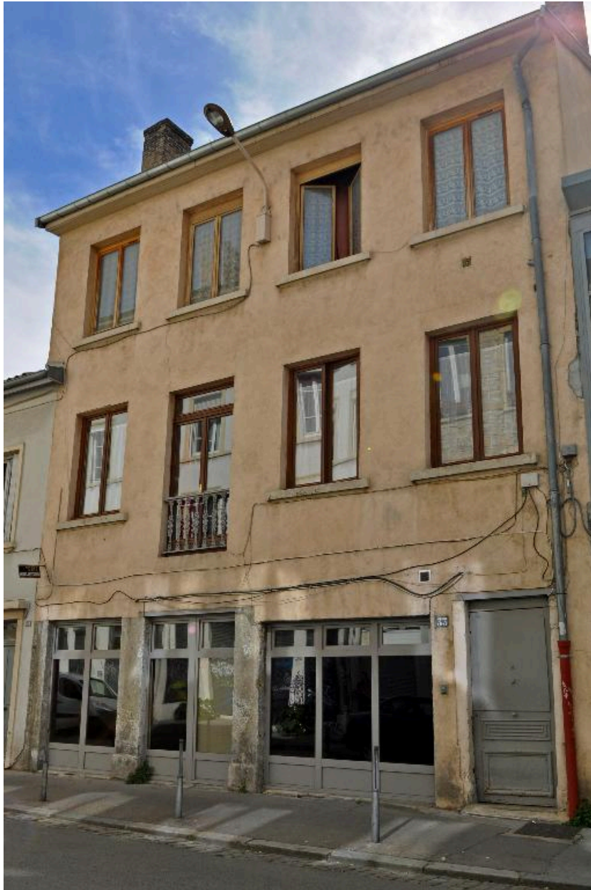
Vue générale, élévation sur rue
