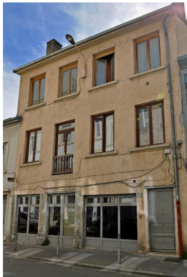
Vue générale, élévation sur rue Phot. Catherine Guégan IVR84_20176901071NUCA
