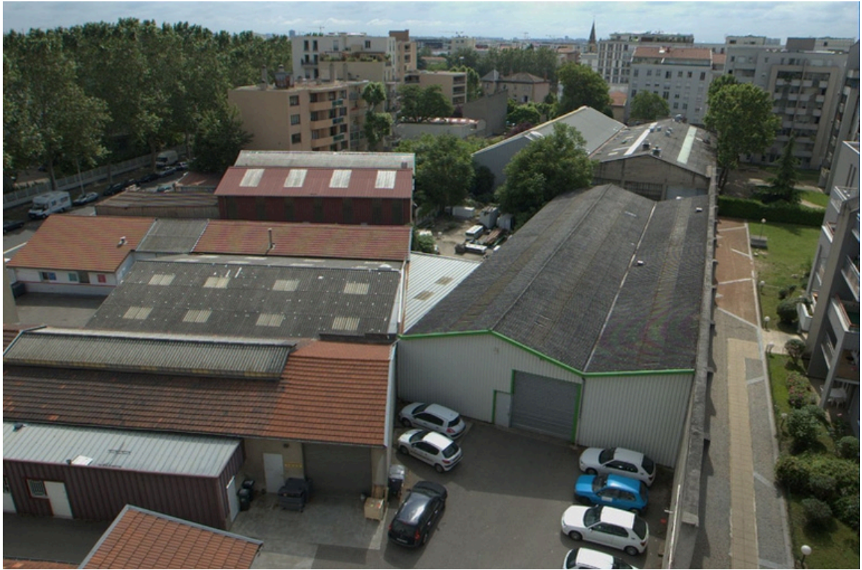
Vue d'ensemble en lien avec la rue des Girondins
