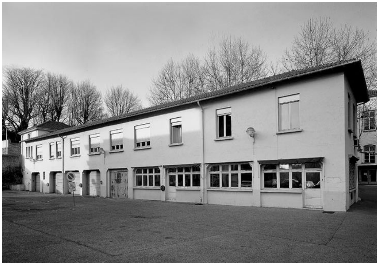
Pavillon de l'administration (23), façade sud
