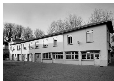
Pavillon de l'administration (23), façade sud Phot. Jean-Marie Refflé IVR82_20016900801P
