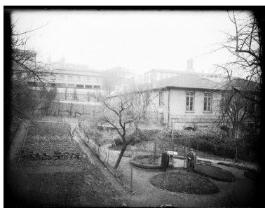
Vue d'ensemble du jardin potager et du bâtiment de la Lingerie, fotogr. par l'abbé Amphoux, ca 1920-1940 IVR82_20036903508NUCB
