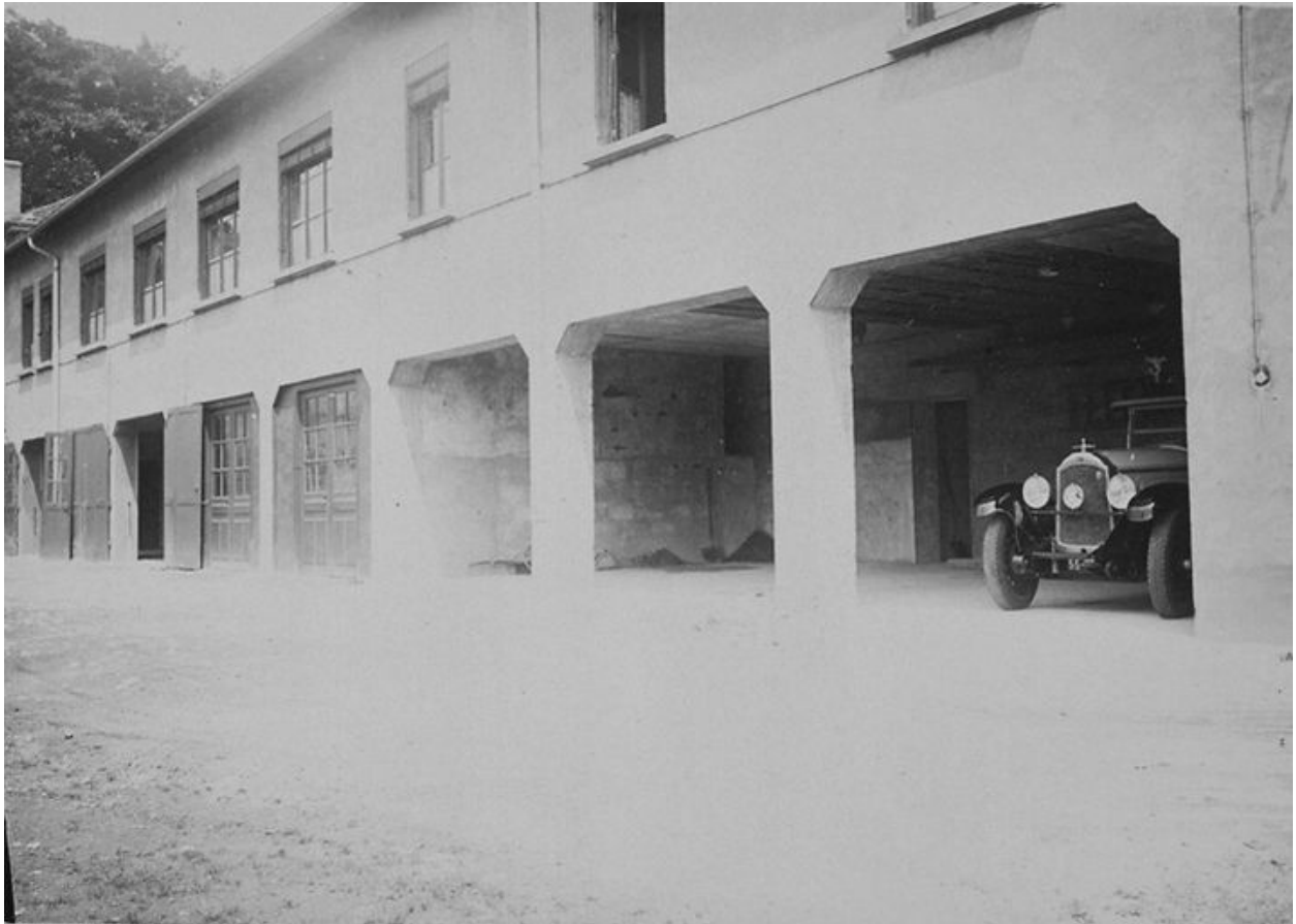
Pavillon d'administration (23), façade postérieure, fotogr. ca 1935
