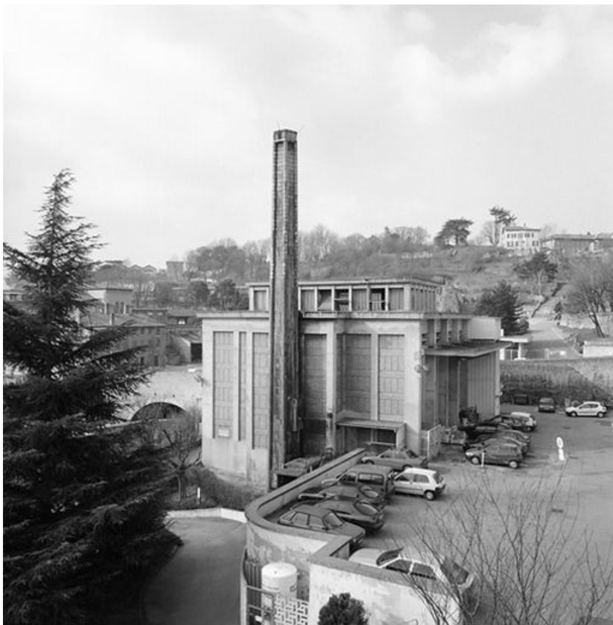
Chaufferie (25), vue générale sur l'angle nord-est
