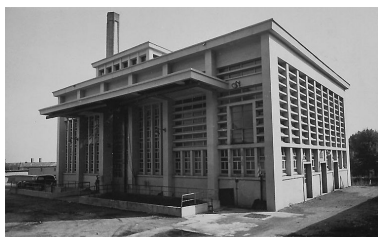
Antiquaille. La nouvelle chaufferie, photogr. par Blanc et Demilly, 1960 Repro. Jean-Marie Refflé IVR82_20026900684XAB
