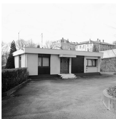
Pavillon de logement du directeur (32), façade nord Phot. Jean-Marie Refflé IVR82_20016900807X
