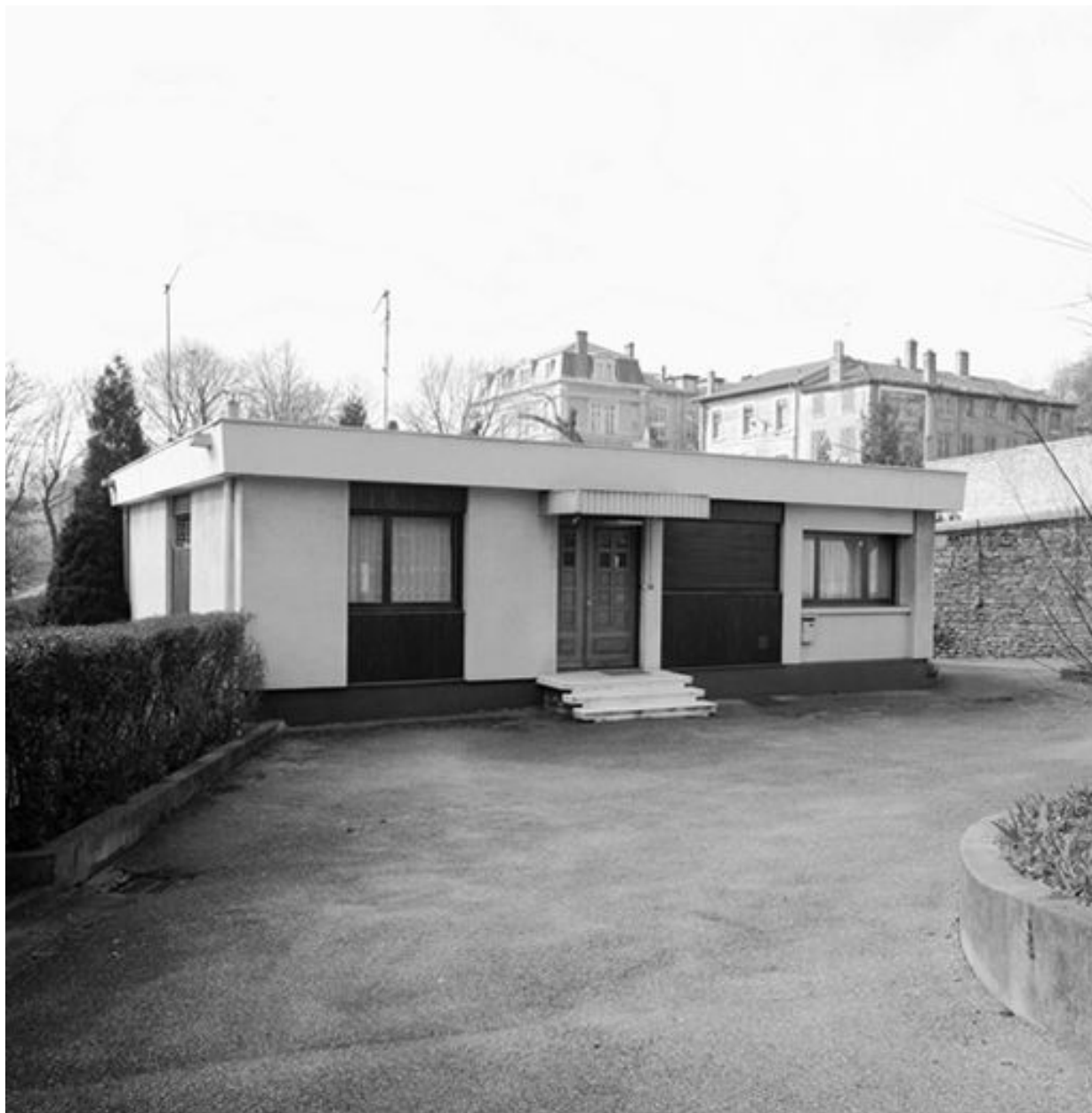
Pavillon de logement du directeur (32), façade nord
