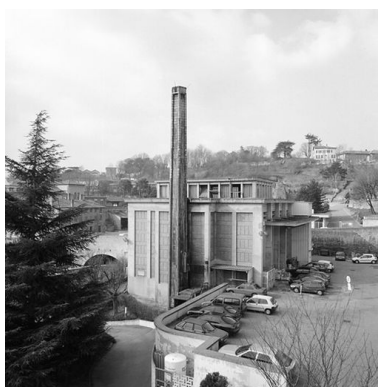
Chaufferie (25), vue générale sur l'angle nord-est Phot. Jean-Marie Refflé IVR82_20016900796X
