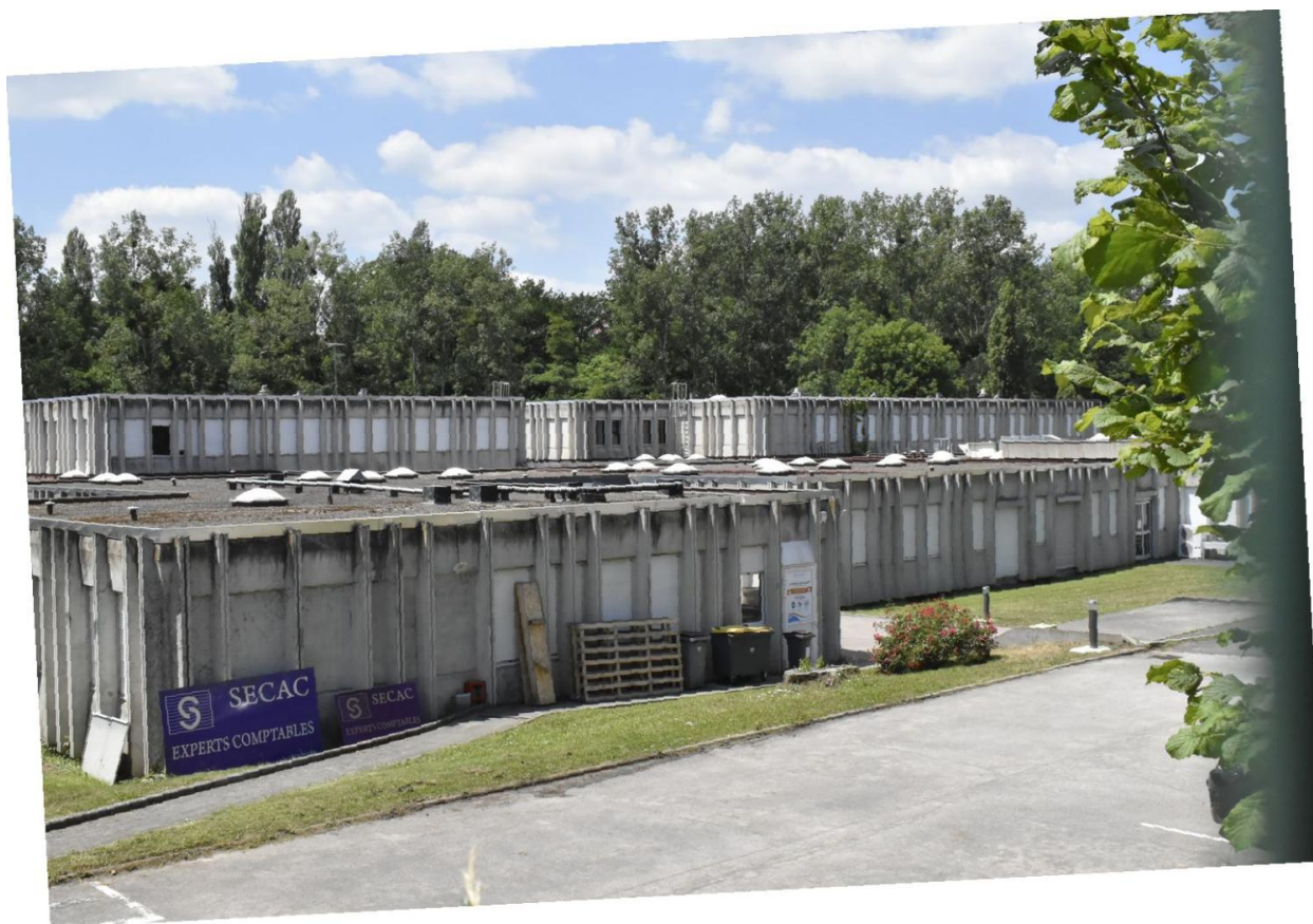
Vue depuis la rue Ernest-Montusès sur les bâtiments en rez-de-chaussée des ateliers (d'après le plan-masse de P. Lagneau). L'éclairage des ateliers provient en partie zénithalement des dômes en plexiglas.
