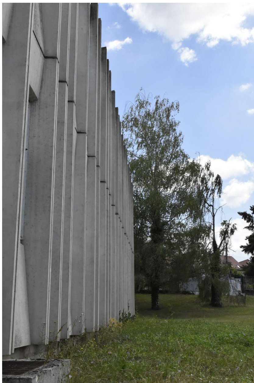
Vue en perspective d la façade du bâtiment des logements de fonction.
