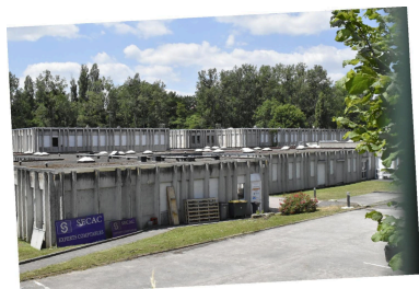
Vue depuis la rue Ernest-Montuses sur les bâtiments en rez-de-chaussée des ateliers (d'après le plan-masse de P. Lagneau). L'éclairage des ateliers provient en partie zénithalement des dômes en plexiglas. Phot. Bénédicte Renaud-Morand IVR84_20230300025NUCA
