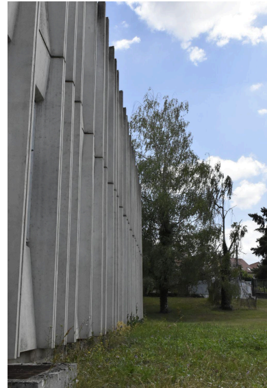
Vue en perspective de la façade du bâtiment des logements de fonction. Phot. Bénédicte Renaud-Morand IVR84_20230300020NUCA
