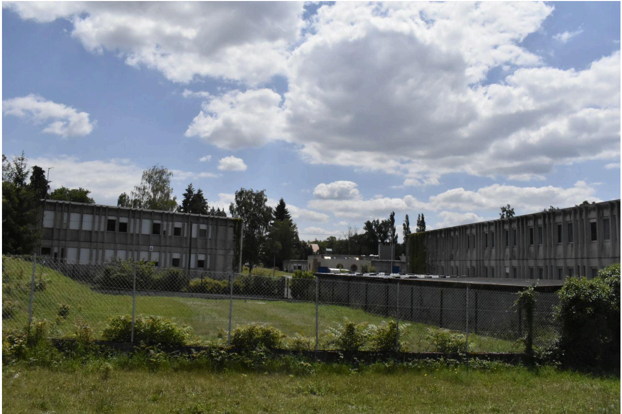
Vue sur le bâtiment des logements de fonction et sur l'internat des garçons depuis le nord (au premier plan, des garages ajoutés en 1986).
