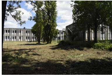
Vue sur l'angle formé par l'internat des filles (à gauche) et l'externat (d'après le plan-masse d'origine de P. Lagneau). Au premier plan la partie la plus à l'ouest de la cour de récréation.
