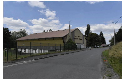
Gymnase (COSEC, complexe sportif évolutif, par Jean Marol, architecte de Vichy) construit en lien avec le CET devenu lycée (à l'arrière-plan) et pour "répondre également à la demande de la population du quartier", entre 1980 et 1985 (plans datés de 1980, AC Montluçon. 4 M 53/A). Phot. Bénédicte Renaud-Morand IVR84_20230300003NUCA
