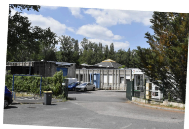
Vue sur l'entrée destinée à desservir directement la cour de service affectée aux ateliers (d'après le plan-masse d'origine de Paul Lagneau). Phot. Bénédicte Renaud-Morand IVR84_20230300024NUCA
