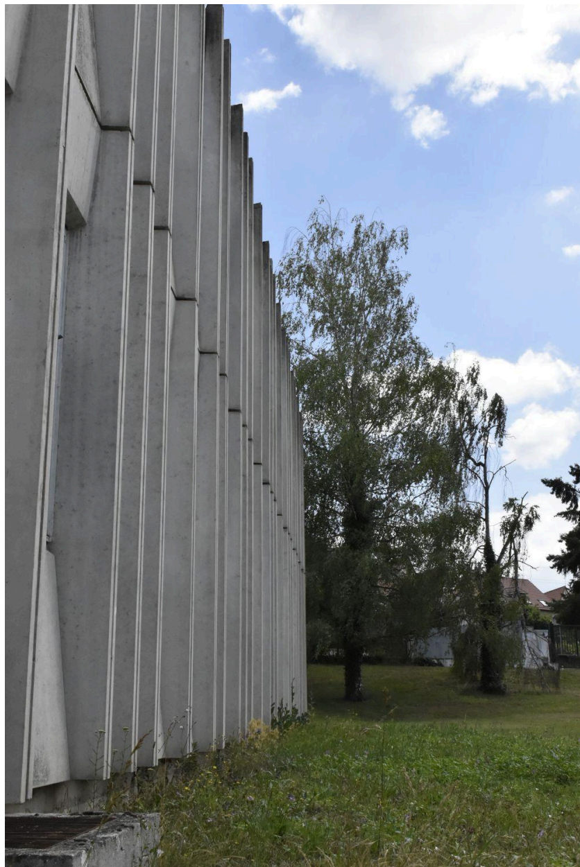
Vue en perspective de la façade du bâtiment des logements de fonction.
