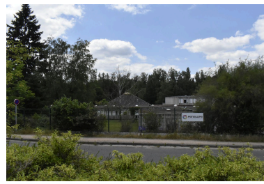
Vue depuis l'espace public, en contre-haut de la rue Ernest-Montuses, sur le lycée et en particulier sur le "bloc-pyramide" ajouté entre juin 1993 et août 1994 à la construction de Paul Lagneau. Phot. Bénédicte Renaud-Morand IVR84_20230300019NUCA
