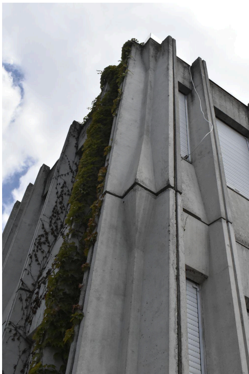
Détail de l'angle du bâtiment des logements de fonction.
