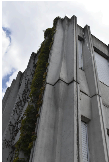
Détail de l'angle du bâtiment des logements de fonction. Phot. Bénédicte Renaud-Morand IVR84_20230300009NUCA
