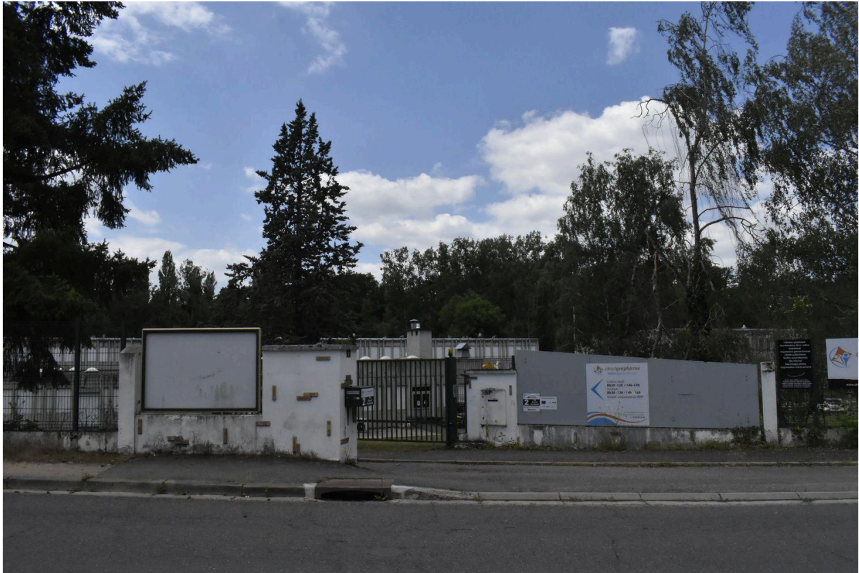
Entrée principale de l'établissement (menant à l'accueil et au bâtiment d'administration), réaffecté depuis 2016.
