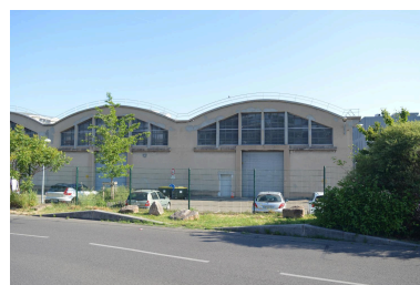
Bâtiment de l'ancien Arsenal de Vénissieux vu depuis la rue Roger Planchon - mai 2022 Phot. Alice Giacovelli IVR84_20226900984NUCA
