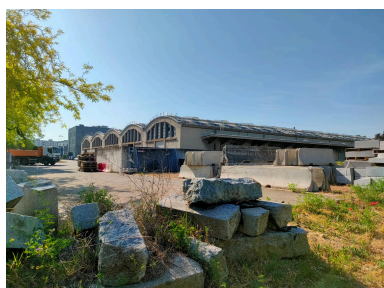
Bâtiment intéressant de l'ancien Arsenal de Vénissieux vu depuis la rue Roger Planchon Phot. Alice Giacovelli IVR84_20226900450NUCA
