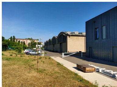
Bâtiment de l'ancien Arsenal de Vénissieux vu depuis la rue Roger Planchon - mai 2022 Phot. Alice Giacovelli IVR84_20226900447NUCA
