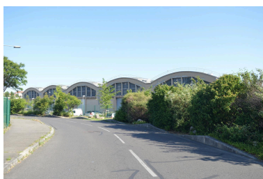
Bâtiment de l'ancien Arsenal de Vénissieux vu depuis la rue Roger Planchon - mai 2022 Phot. Alice Giacovelli IVR84_20226900983NUCA
