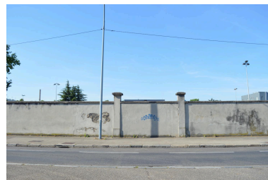
Mur d'enceinte de l'ancien Arsenal de Vénissieux vu depuis l'avenue de la République - mai 2022 Phot. Alice Giacovelli IVR84_20226901003NUCA
