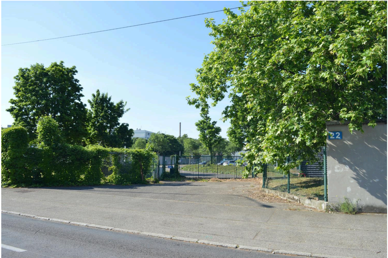
Extrémité du mur d'enceinte de l'ancien Arsenal de Vénissieux vu depuis l'avenue de la République - mai 2022
