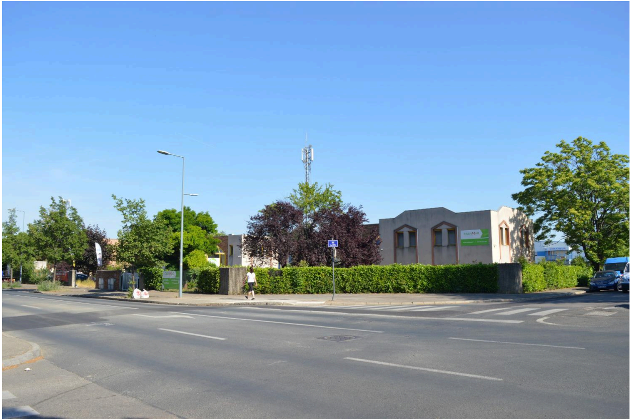
Site de l'ancien Arsenal de Vénissieux vu depuis le croisement de la rue Roger Planchon et de l'avenue de la République - mai 2022
