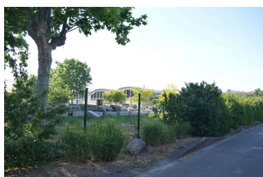
Bâtiment de l'ancien Arsenal de Vénissieux vu depuis la rue Roger Planchon - mai 2022 Phot. Alice Giacovelli IVR84_20226900989NUCA
