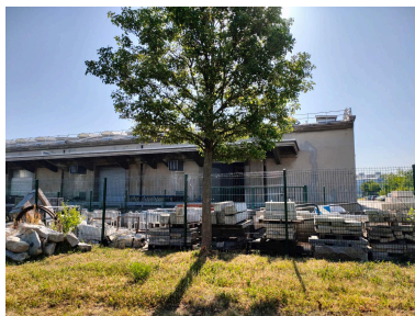
Bâtiment de l'ancien Arsenal de Vénissieux vu depuis la rue Roger Planchon - mai 2022 Phot. Alice Giacovelli IVR84_20226900448NUCA
