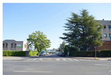
Site de l'ancien Arsenal de Vénissieux vu depuis le croisement de la rue Roger Planchon et de l'avenue de la République - mai 2022 Phot. Alice Giacovelli IVR84_20226900993NUCA
