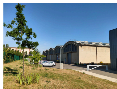
Bâtiment de l'ancien Arsenal de Vénissieux vu depuis la rue Roger Planchon - mai 2022 Phot. Alice Giacovelli IVR84_20226900446NUCA
