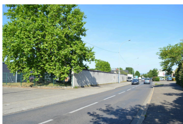
Mur d'enceinte de l'ancien Arsenal de Vénissieux vu depuis l'avenue de la République - mai 2022 Phot. Alice Giacovelli IVR84_20226901005NUCA
