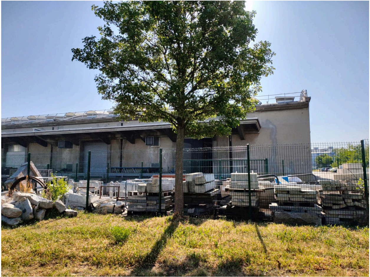
Bâtiment de l'ancien Arsenal de Vénissieux vu depuis la rue Roger Planchon - mai 2022
