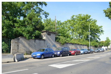
Mur d'enceinte de l'ancien Arsenal de Vénissieux vu depuis l'avenue de la République - mai 2022 Phot. Alice Giacovelli IVR84_20226900998NUCA
