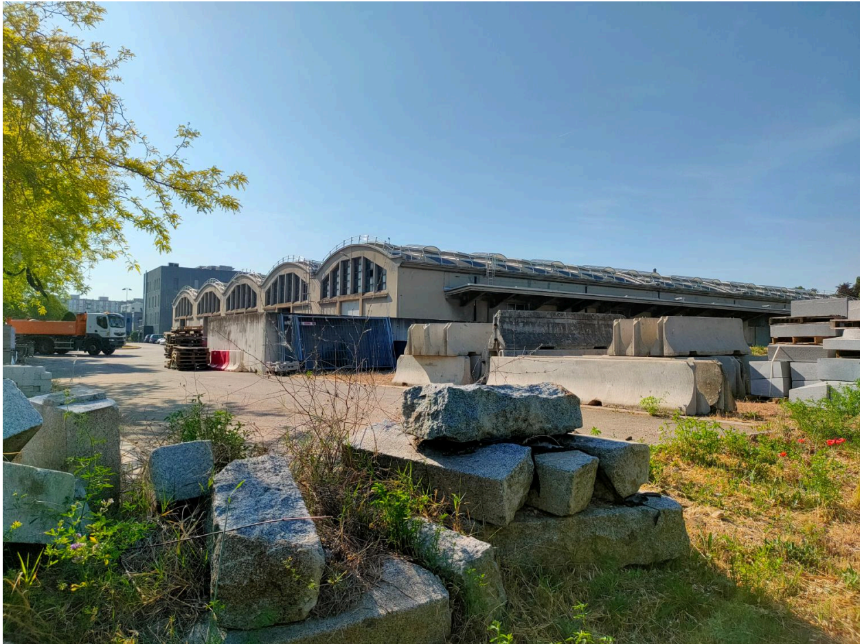
Bâtiment intéressant de l'ancien Arsenal de Vénissieux vu depuis la rue Roger Planchon
