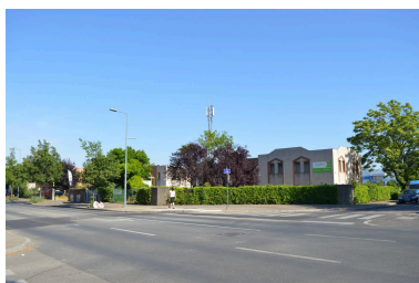
Site de l'ancien Arsenal de Vénissieux vu depuis le croisement de la rue Roger Planchon et de l'avenue de la République - mai 2022 Phot. Alice Giacovelli IVR84_20226900996NUCA
