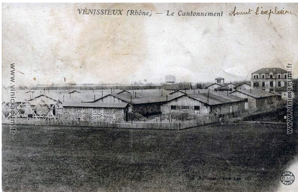
Vénissieux (Rhône) - Le cantonnement "avant l'explosion" (Association Viniciacum)
