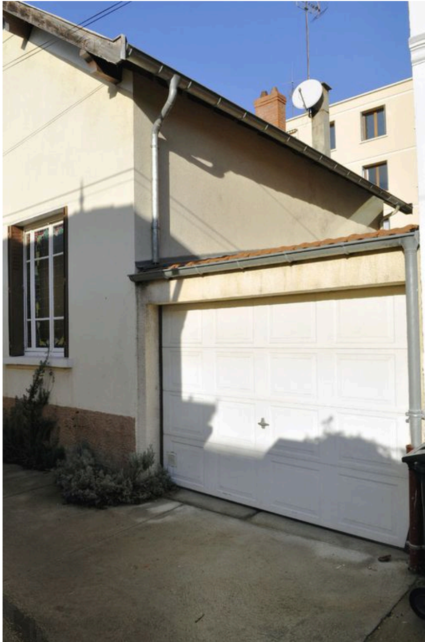
Façade antérieure, vue sur le garage avant travaux.
