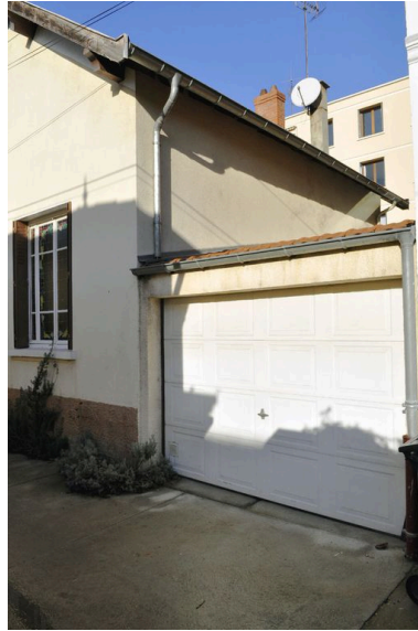
Façade antérieure, vue sur le garage avant travaux. Phot. Julien Defillon IVR82_20106900801NUCA
