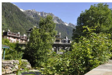
Vue du tablier métallique en face aval Phot. Samir Mahfoudi IVR84_20207401352NUCA
