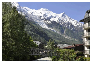
Vue générale de l'ouvrage Phot. Samir Mahfoudi IVR84_20207401351NUCA
