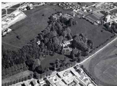
Vue aérienne du domaine Repro. François Fouger IVR82_20057300661NUCB
