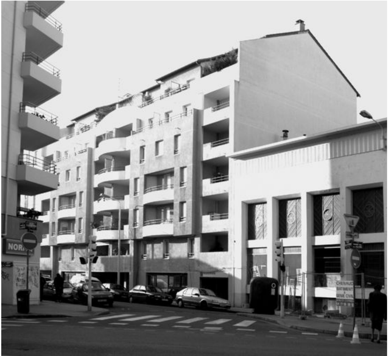
Elévation antérieure, vue partielle
