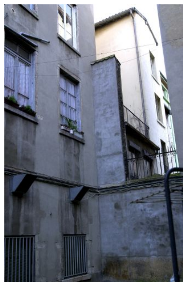
Elévation postérieure. Détail. Phot. Maryannick Chalabi IVR82_20016900234NUCA
