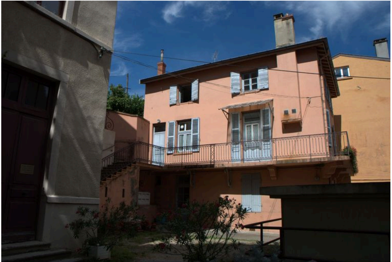
Vue de l'élévation sud
