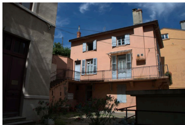
Vue de l'élévation sud Phot. Catherine Guégan IVR82_20086901449NUCA
