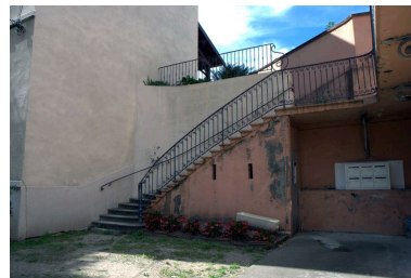
Escalier extérieur conduisant au premier étage Phot. Catherine Guégan IVR82_20086901450NUCA
