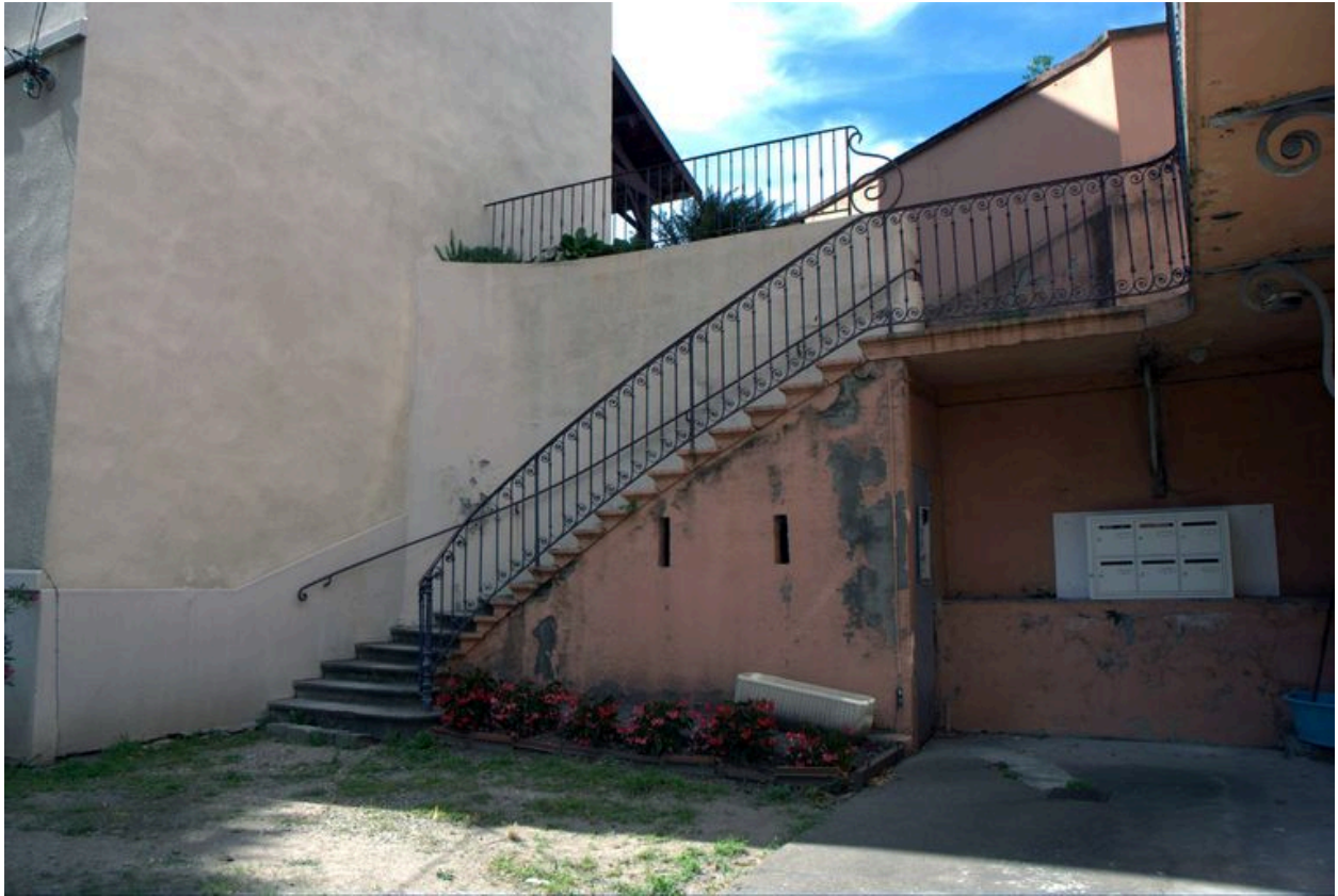
Escalier extérieur conduisant au premier étage
