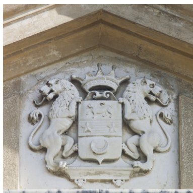
Détail de la façade sur cour : armoiries du fronton. Phot. Didier Gourbin IVR82_20054202122NUCA
