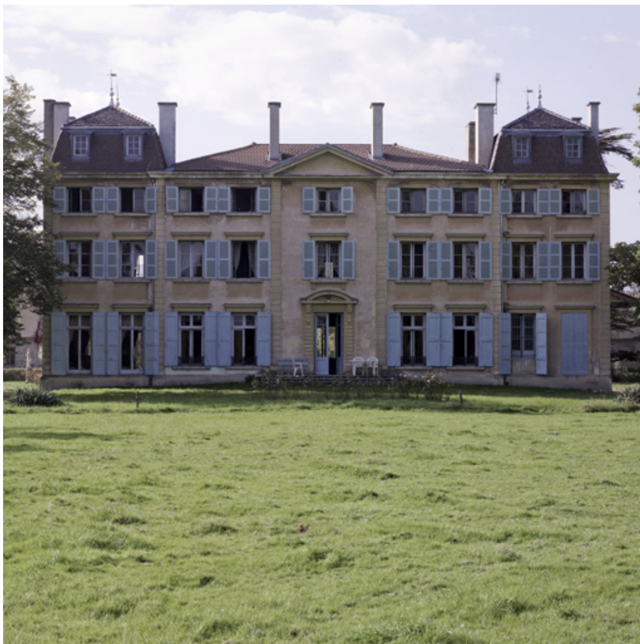
Vue d'ensemble de la façade sur jardin.
