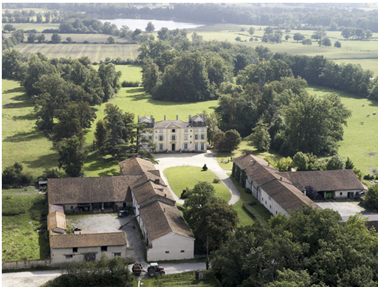
Vue générale aérienne depuis le nord-ouest.
