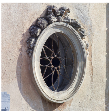
Détail de la façade sur cour : oculus (travée sud). Phot. Didier Gourbin IVR82_20054202124NUCA
