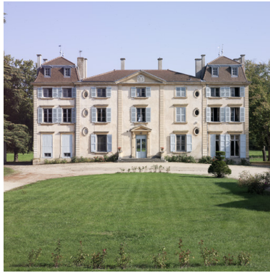
Vue d'ensemble depuis la cour d'honneur. Phot. Didier Gourbin IVR82_20054202121NUCA
