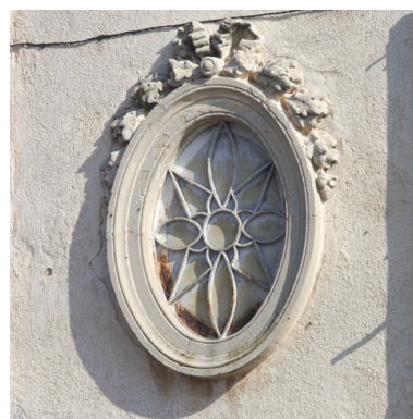
Détail de la façade sur cour : oculus (travée nord). Phot. Didier Gourbin IVR82_20054202123NUCA
