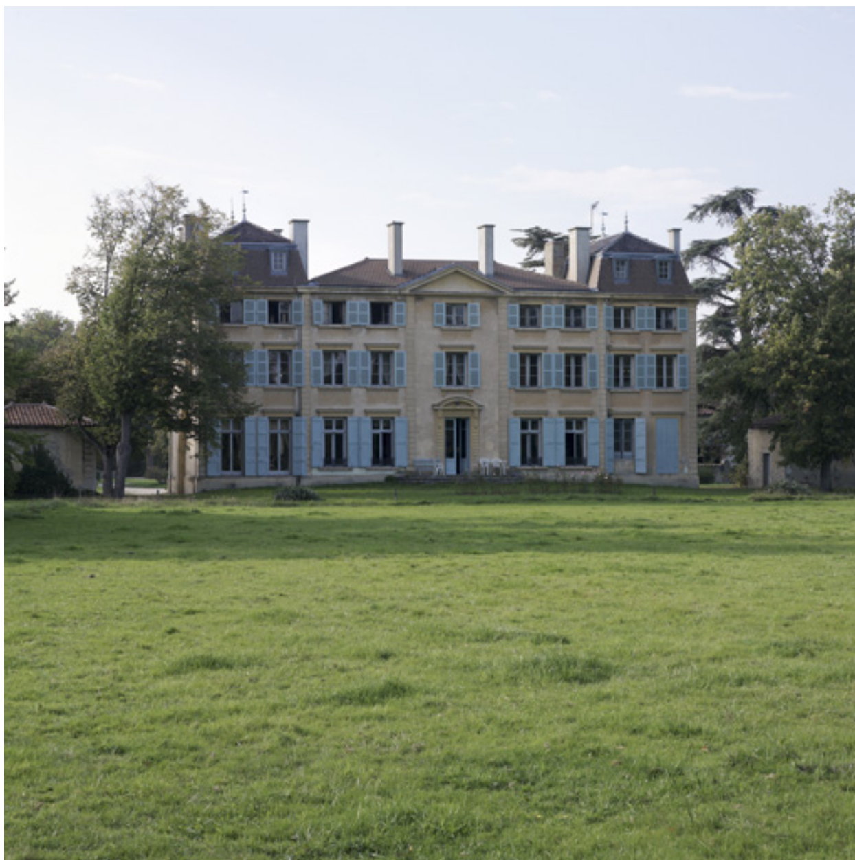
Vue générale de la façade sur jardin.
