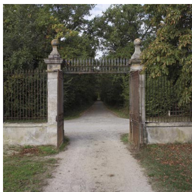
Vue du portail. Phot. Didier Gourbin IVR82_20054202161NUCA
