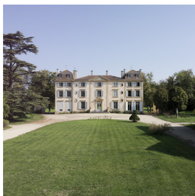
Vue d'ensemble depuis la cour d'honneur. Phot. Didier Gourbin IVR82_20054202120NUCA
