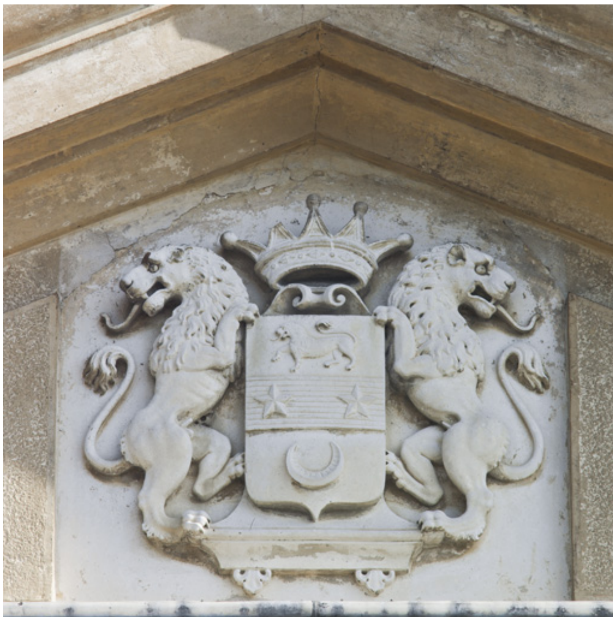
Détail de la façade sur cour : armoiries du fronton.
