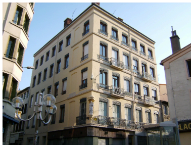
Détail de l'angle Phot. Cendrine Sanquer IVR82_20084200508NUCA
