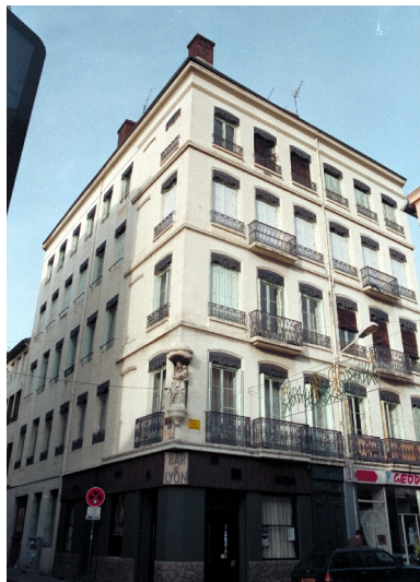
Façade principale Phot. Cendrine Sanquer IVR82_19974201958ZE
