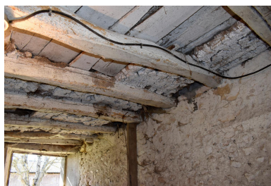
Vue du plafond de la bergerie et des vestiges de torchis. Phot. Cécile Breton IVR84_20240300016NUC4A
