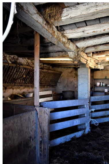
Vue de l'aménagement intérieur de l'étable-bergerie. Phot. Cécile Breton IVR84_20240300018NUC4A
