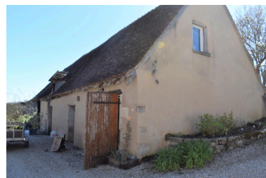
Grange, vue du nord-est Phot. Cécile Breton IVR84_20240300014NUC4A
