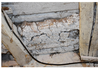
Détails des vestiges de torchis dans la bergerie. Phot. Cécile Breton IVR84_20240300017NUC4A
