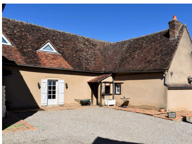
Vue du mur gouttereau sud et de l'aile sud-est. Phot. Cécile Breton IVR84_20240300023NUC4A
