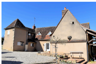
Vue générale de la maison d'habitation, côté sud. Phot. Cécile Breton IVR84_20240300022NUC4A
