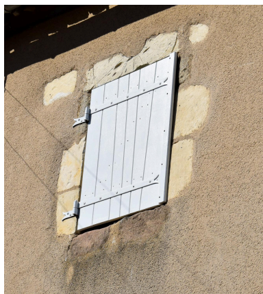
Fenêtre du 1er étage de la tour, détail. Le linteau est un remploi d'un fragment de cadran solaire. Phot. Cécile Breton IVR84_20240300026NUC4A
