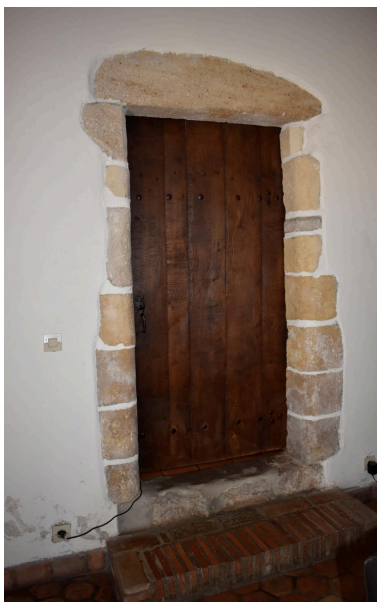
Porte à encadrement de pierre de taille à l'intérieur de l'édifice. Phot. Cécile Breton IVR84_20240300024NUC4A
