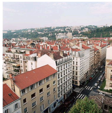
La rue Franklin, vue prise depuis le toit du central téléphonique Ampère Phot. Eric Dessert IVR82_20046901222XE
