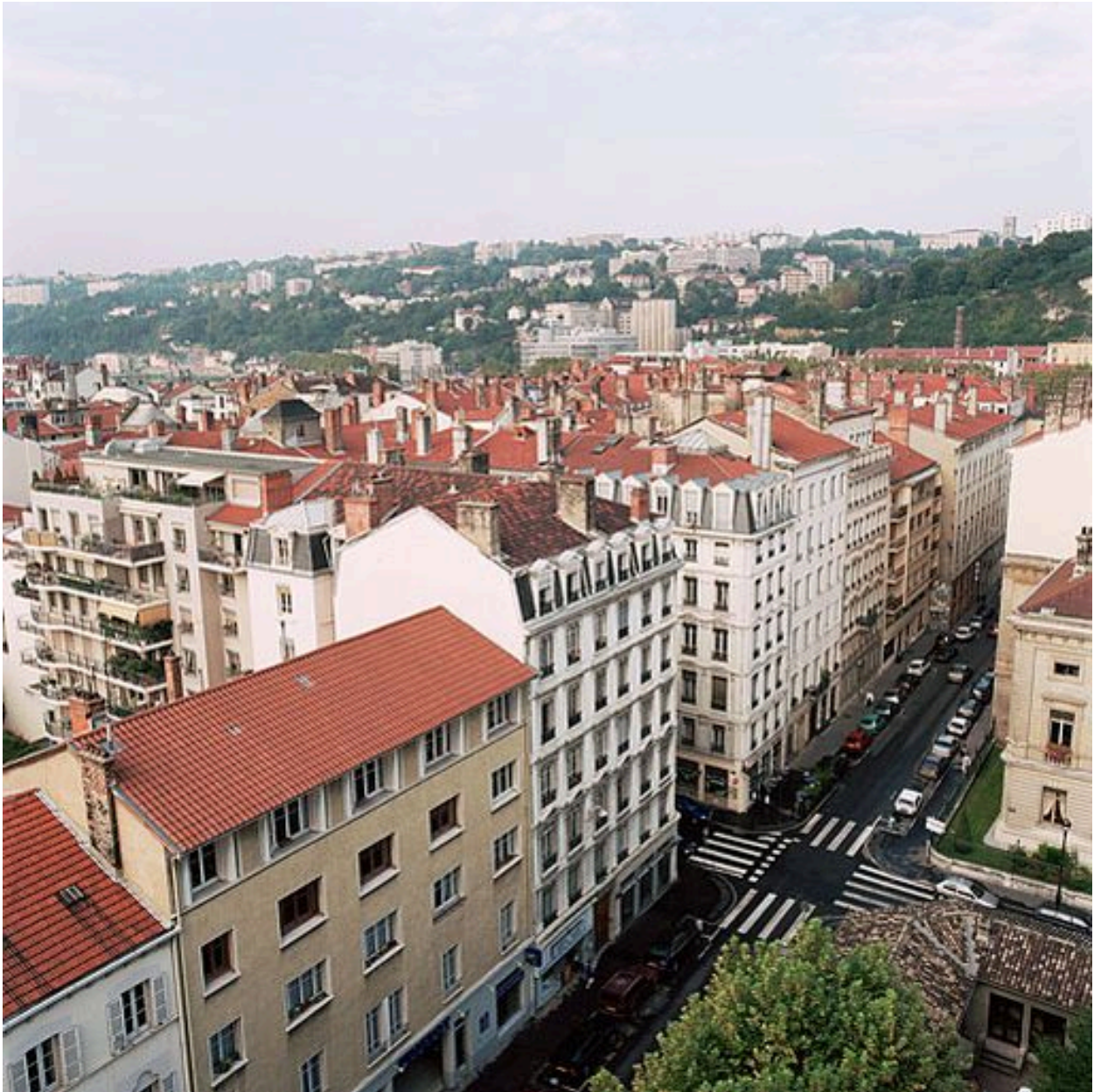
La rue Franklin, vue prise depuis le toit du central téléphonique Ampère
