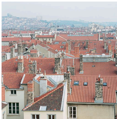
Les toits du quartier d'Ainay vus depuis le central téléphonique Ampère, vers le nord Phot. Eric Dessert IVR82_20046901228XE
