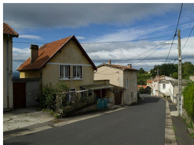
La rue du Point-du-Jour, en direction du centre-ville de Thiers. Phot. Jean-Michel Périn IVR83_20116301022NUC4A
