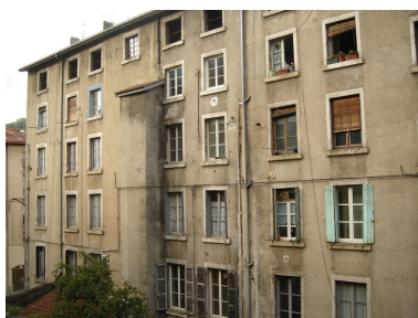
Façade arrière Phot. Isabelle Dupuis IVR82_20093800730NUCA
