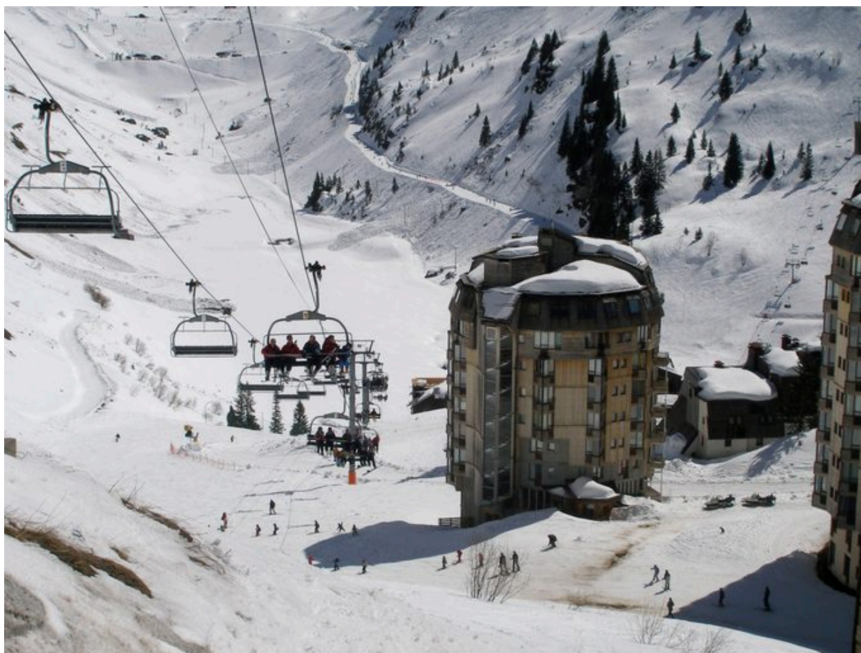
Vue générale depuis le nord
