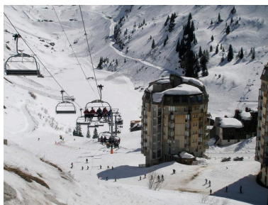
Vue générale depuis le nord Phot. Jean-François Lyon-Caen, Phot. C. Salomon-Pelen IVR82_20087401142NUCA
