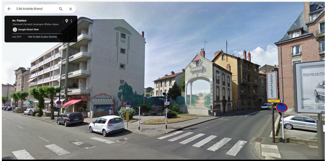
Carrefour du boulevard Aristide-Briand et de l'avenue Pasteur. Avant la construction d'une résidence. Immeubles détruits sur l'avenue Pasteur
