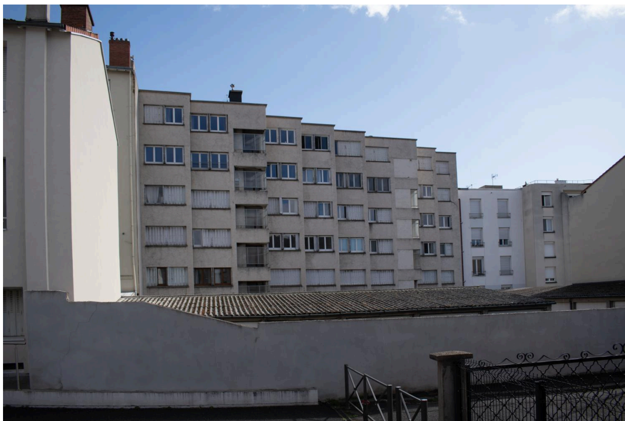
Elévation postérieure, vue depuis le chemin de Beaurepaire
