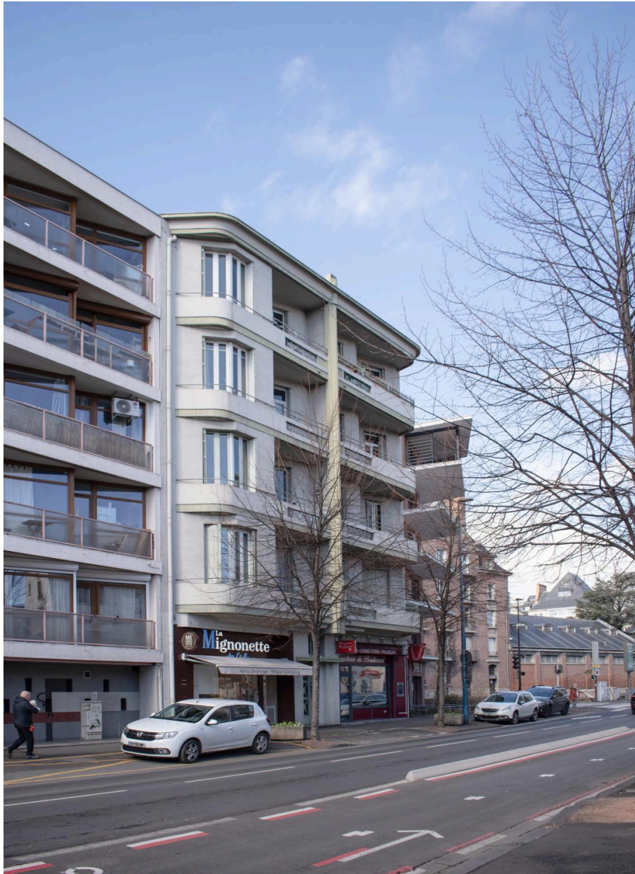
Façade sur le boulevard Aristide-Briand
