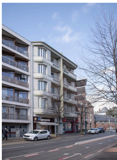
Façade sur le boulevard Aristide-Briand Phot. Félicie Fougère IVR84_20256302422NUCA
