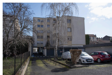
Elévation postérieure, vue depuis le chemin de Beaurepaire Phot. Félicie Fougère IVR84_20256302383NUCA
