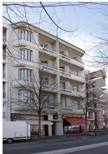
Façade du n°4 sur le boulevard Aristide-Briand (édifice de comparaison) Phot. Félicie Fougère IVR84_20256302420NUCA
