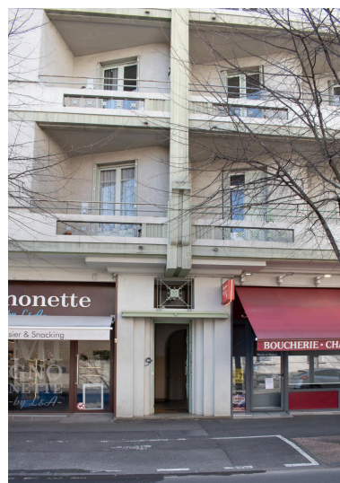
Détail: porte d'entrée et travées centrales Phot. Félicie Fougère IVR84_20256302421NUCA
