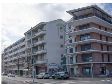
Façades sur le boulevard Aristide-Briand Phot. Félicie Fougère IVR84_20256302423NUCA
