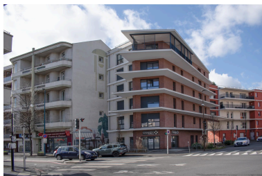
Elévations au carrefour du boulevard Aristide-Briand et de l'avenue Pasteur Phot. Félicie Fougère IVR84_20256302363NUCA
