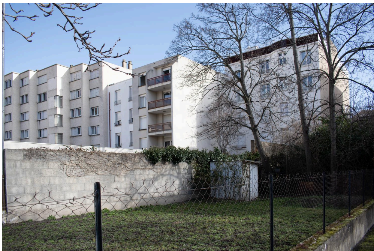
Elévations postérieures et jardin, vue depuis le chemin de Beaurepaire
