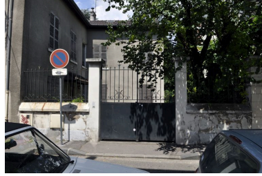
Mur et grille d'entrée Phot. Catherine Guégan IVR82_20096904317NUCA
