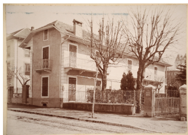
La maison, vers 1898 Repro. François Fouger IVR82_20127300738NUCB
