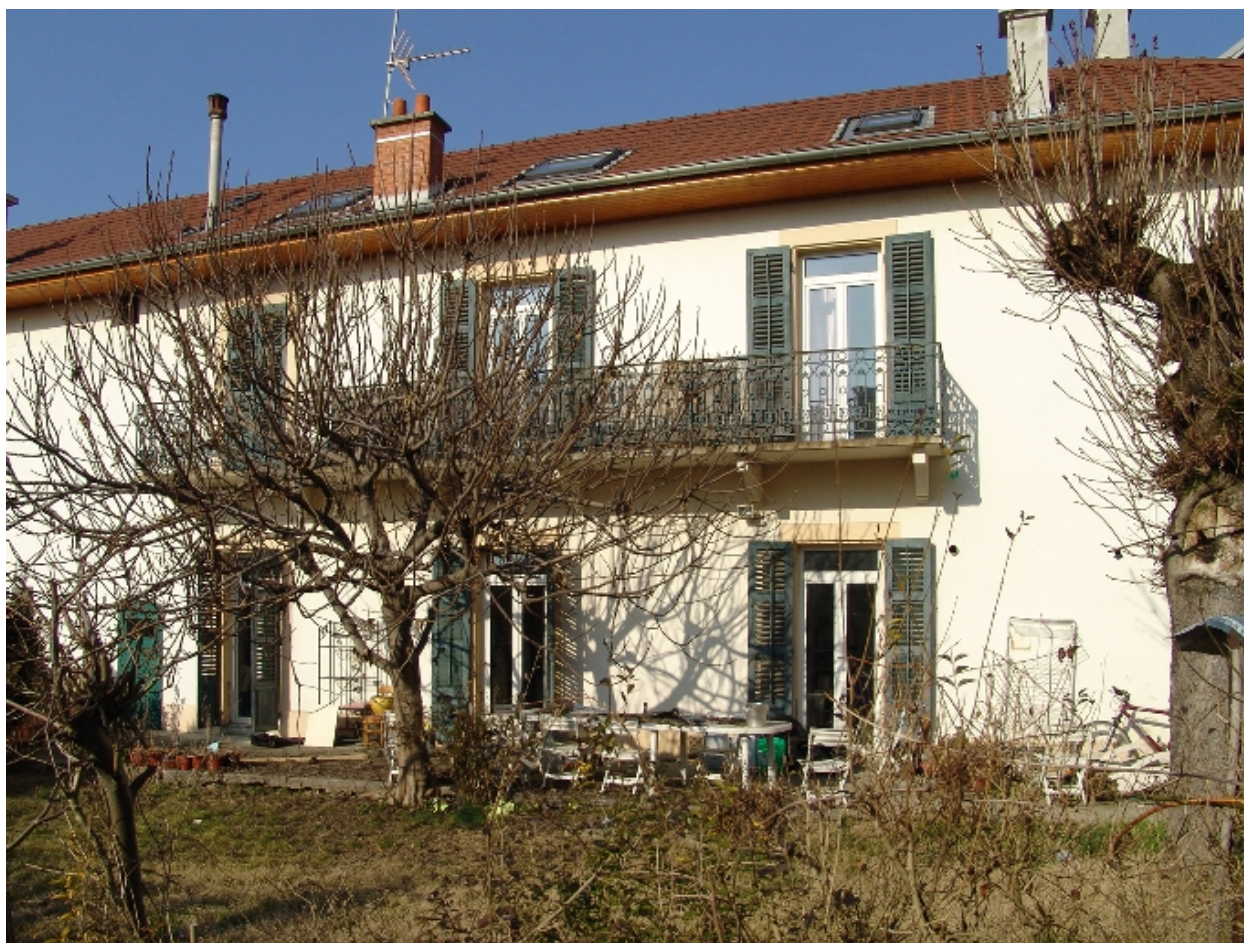
Façade sur jardin, partie droite
