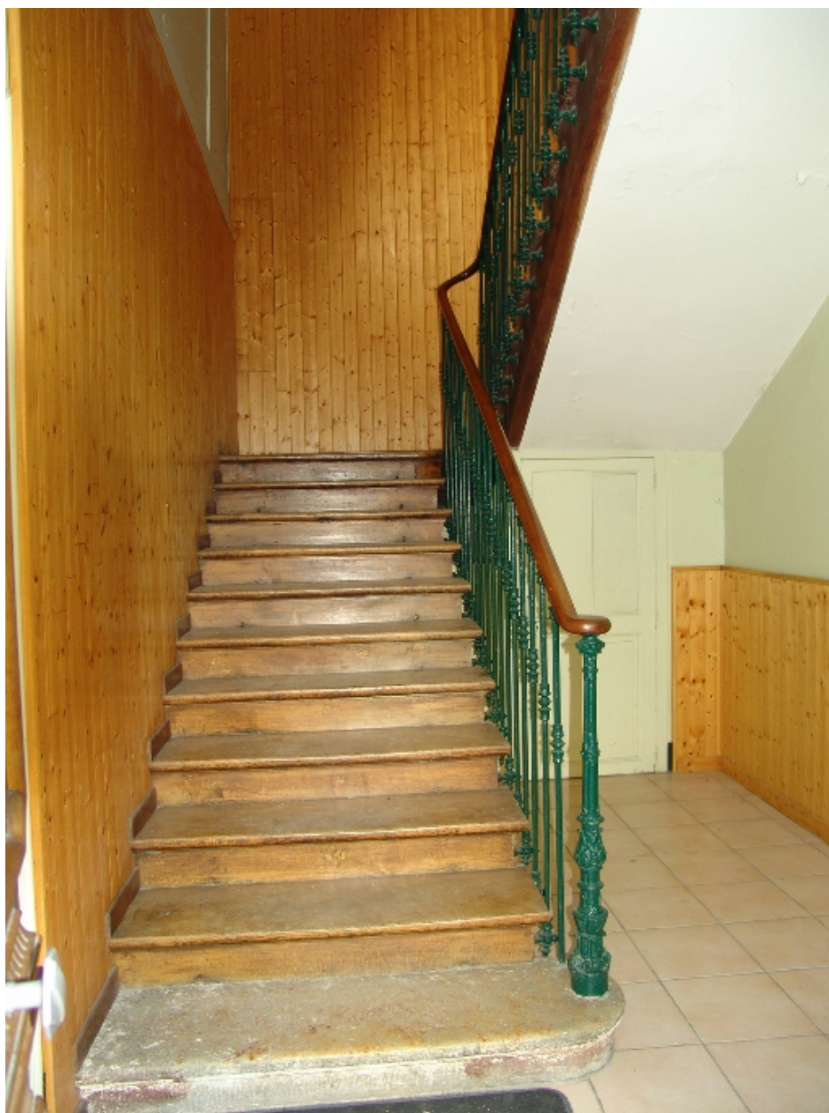
Départ de l'escalier intérieur
