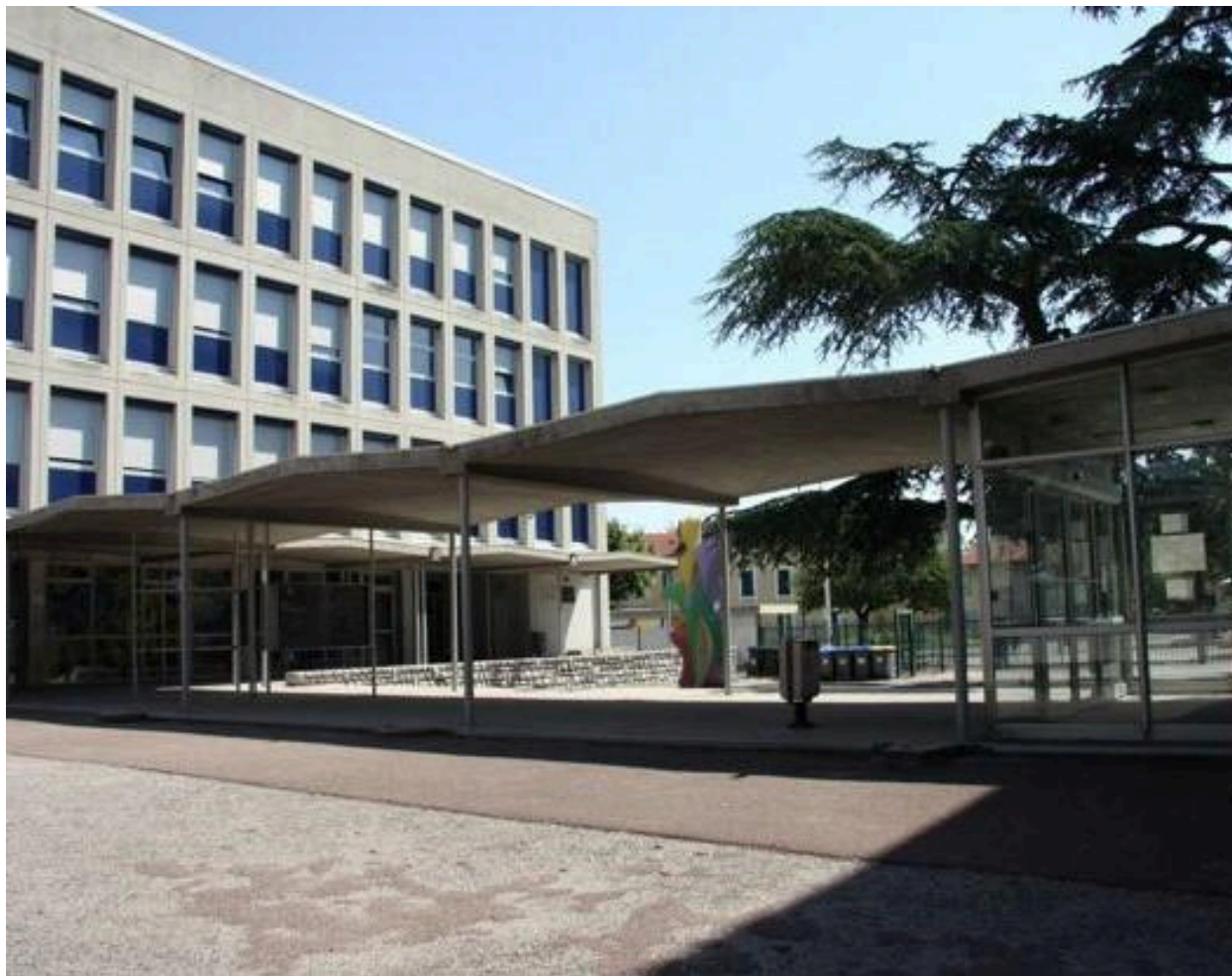
Vue de la cour et de la galerie couverte, avant travaux de restructuration
