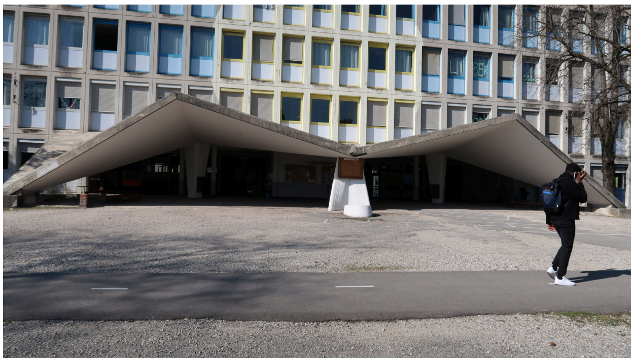
Vue partielle du bâtiment principal avant restructuration
