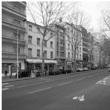
Elévation cours Gambetta depuis l'est
