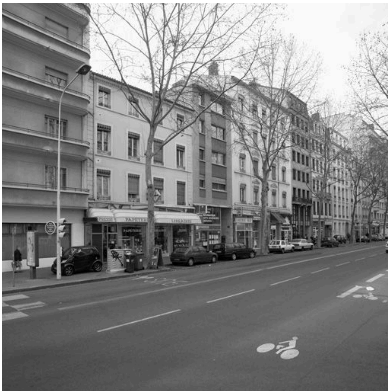
Elévation cours Gambetta depuis l'est
