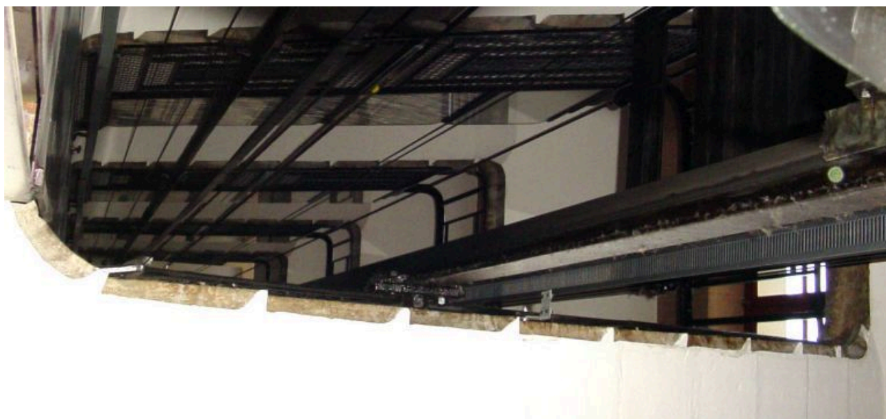
Cage d'escalier vu du dessous
