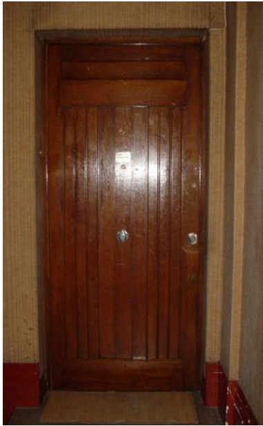
Huisseries des portes palières Phot. Anaïs Beccaria IVR82_20046903377NUCA
