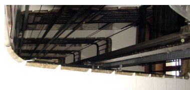
Cage d'escalier vu du dessous Phot. Anaïs Beccaria IVR82_20046903376NUCA
