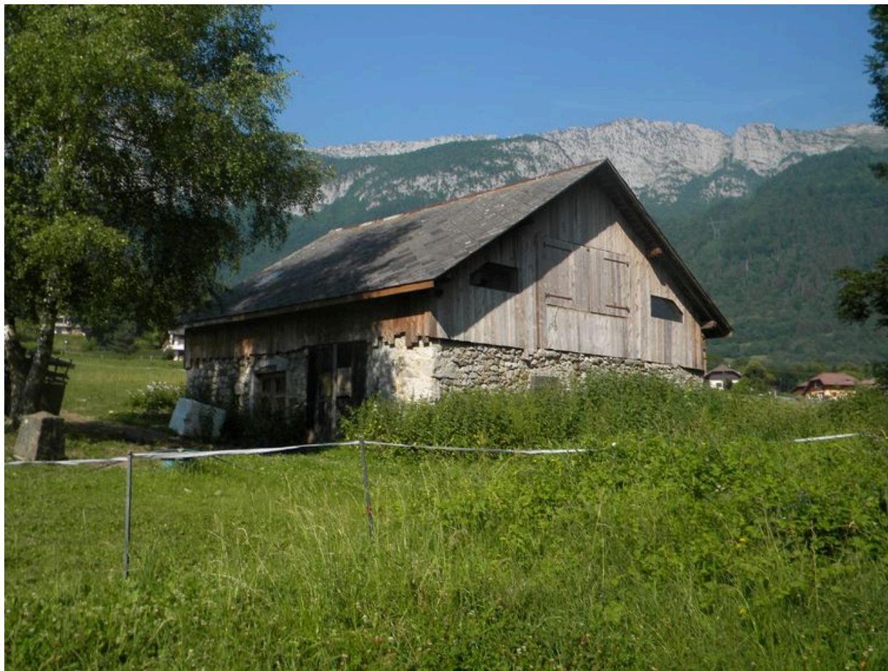
Vue générale d'une grange isolée au Jourdy (2008 A1 1152, 1153)
