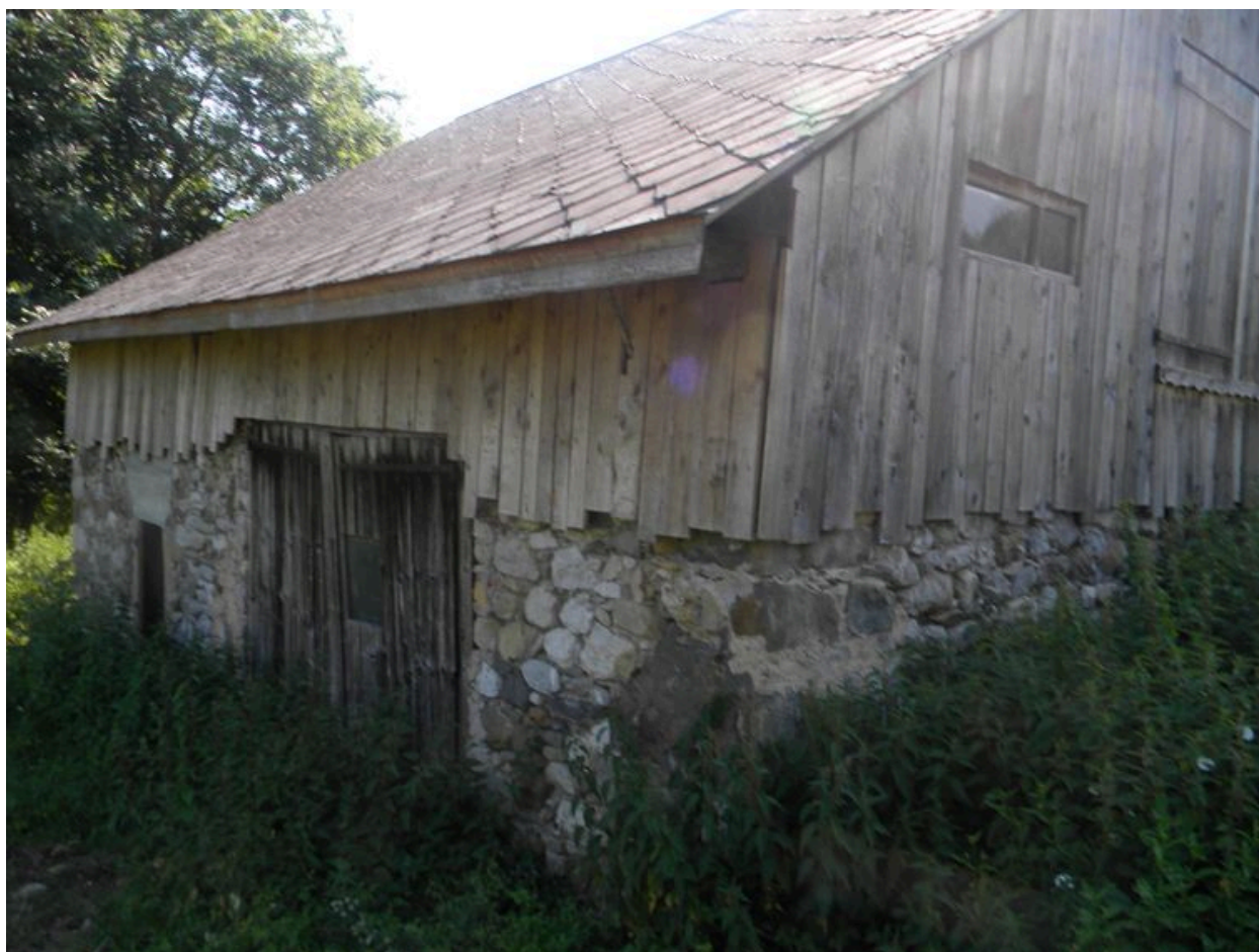
Façade arrière d'une grange isolée au Jourdy (2008 A1 1152, 1153)
