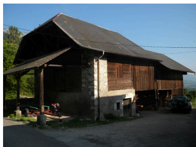
Vue d'un bâtiment agricole à Marceau-dessus (2008 A1 39). Phot. Jérôme Daviet IVR82_20127400609NUCA
