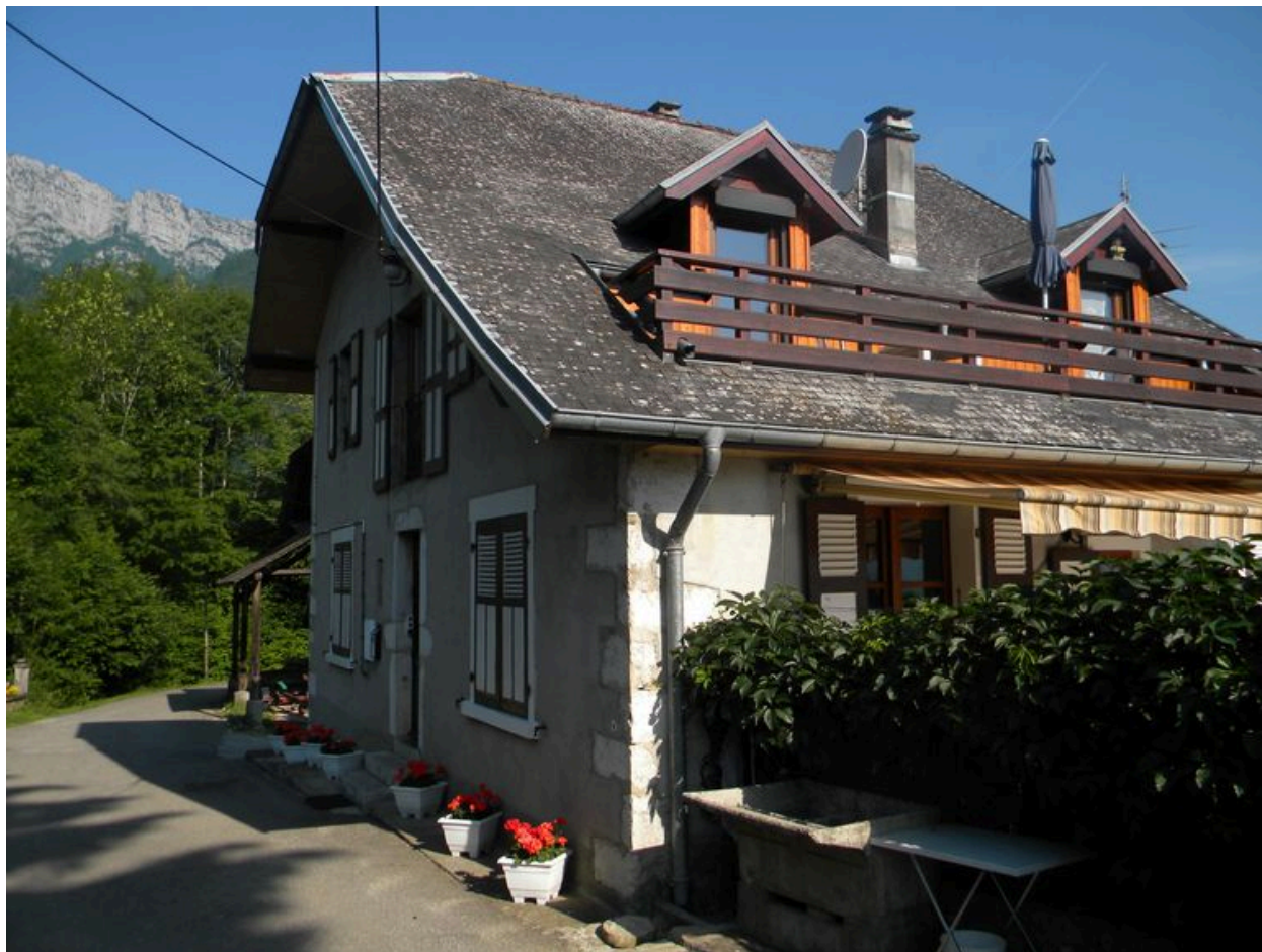
Vue de la façade principale d'une ancienne ferme mitoyenne (2008 A1 11154)
