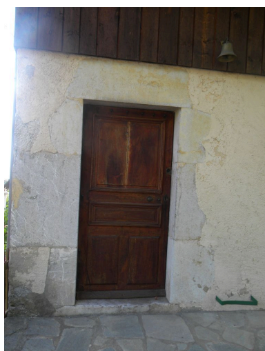
Encadrement de porte en marbre de Doussard sur une ancienne maison (2008 A1 48) Phot. Jérôme Daviet IVR82_20127400633NUCA
