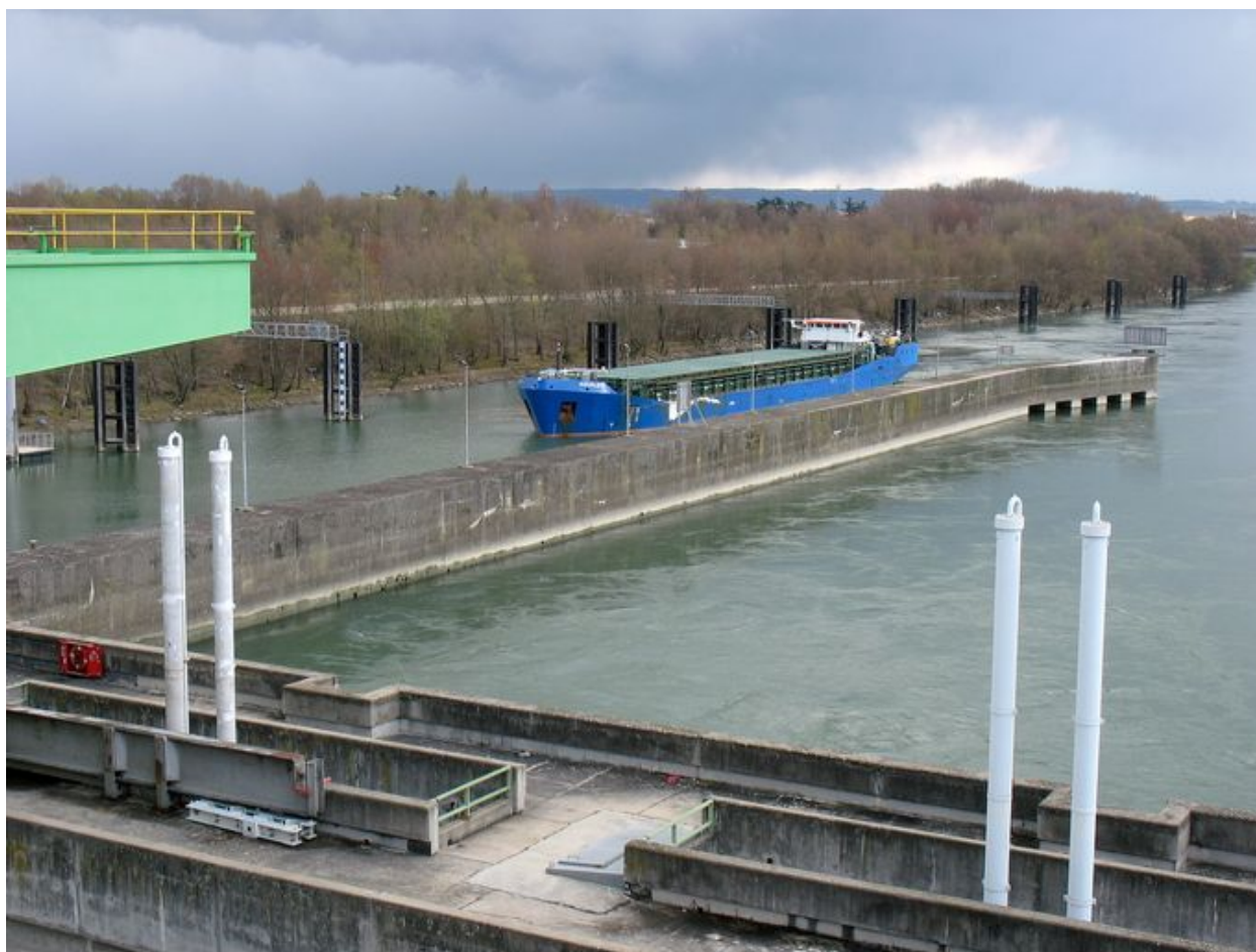
Vue partielle côté aval : mur guide aval
