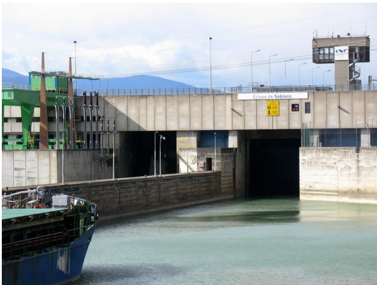
Vue partielle, écluse, côté aval
