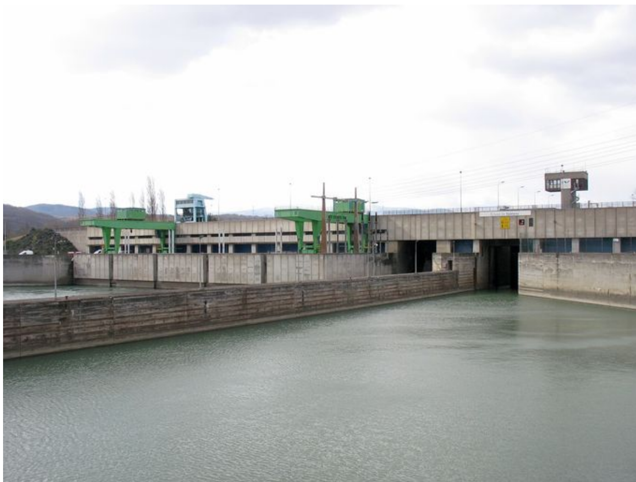
Vue côté aval (depuis la rive gauche)
