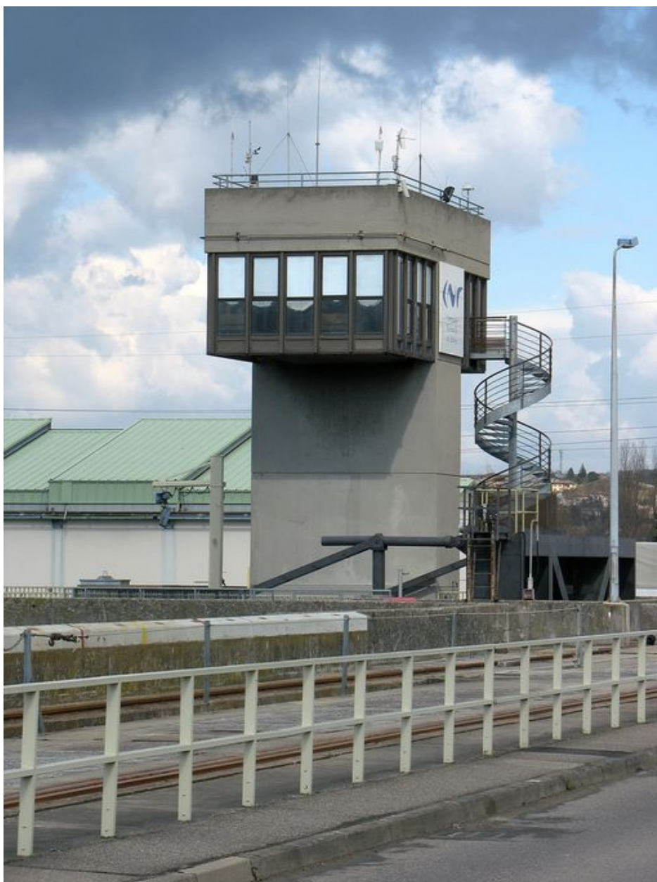
Ecluse : vue du poste de contrôle
