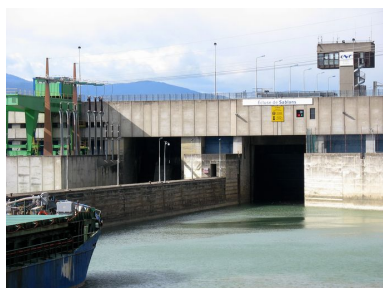
Vue partielle, écluse, côté aval Phot. F. Griot
