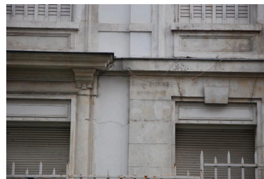
Détails de la signature et de la date portées Phot. Catherine Guégan IVR84_20176902227NUCA
