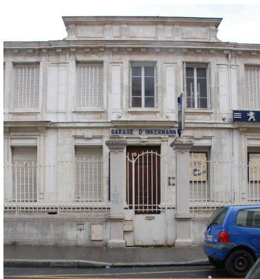
Détail de la façade principale Phot. Catherine Guégan IVR84_20176902225NUCA
