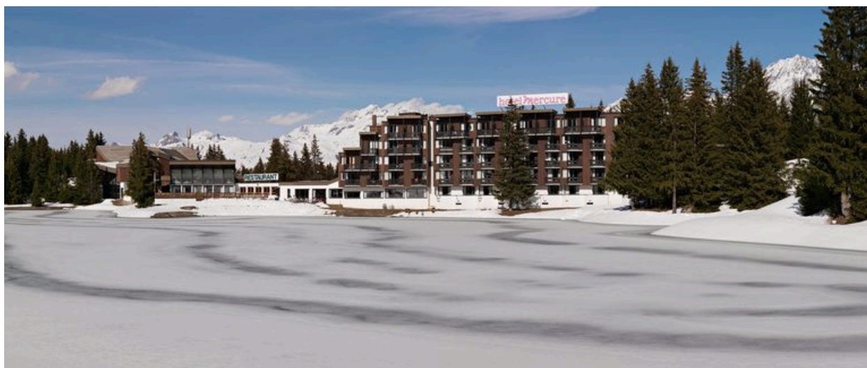
Vue d'ensemble de l'Auditorium et de l'hôtel depuis le lac des Verdon à l'ouest
