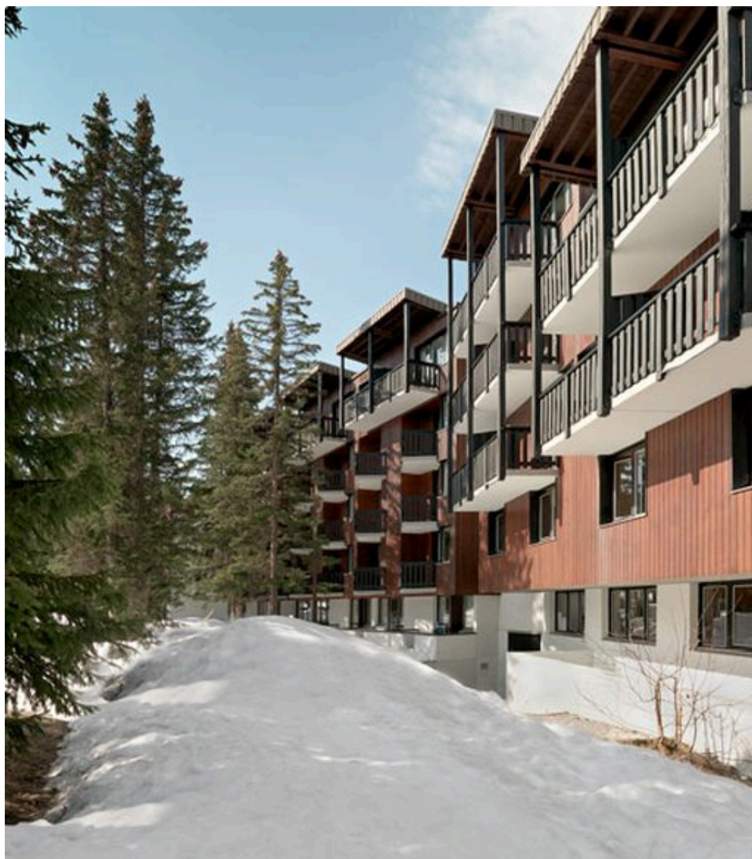
Elévation nord-est de l'hôtel Mercure
