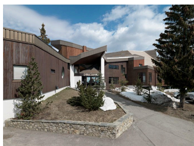
Entrée de l'Auditorium Phot. Eric Dessert IVR82_20107303702NUCA
