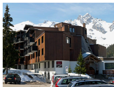
Hotel Mercure. L'entrée et l'élévation nord-est Phot. Eric Dessert IVR82_20107303741NUCA
