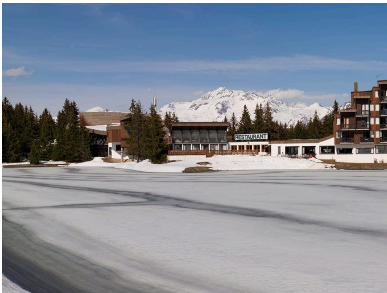
La liaison (salle de restaurant) entre l'Auditorium et l'hôtel depuis le lac des Verdon à l'ouest
