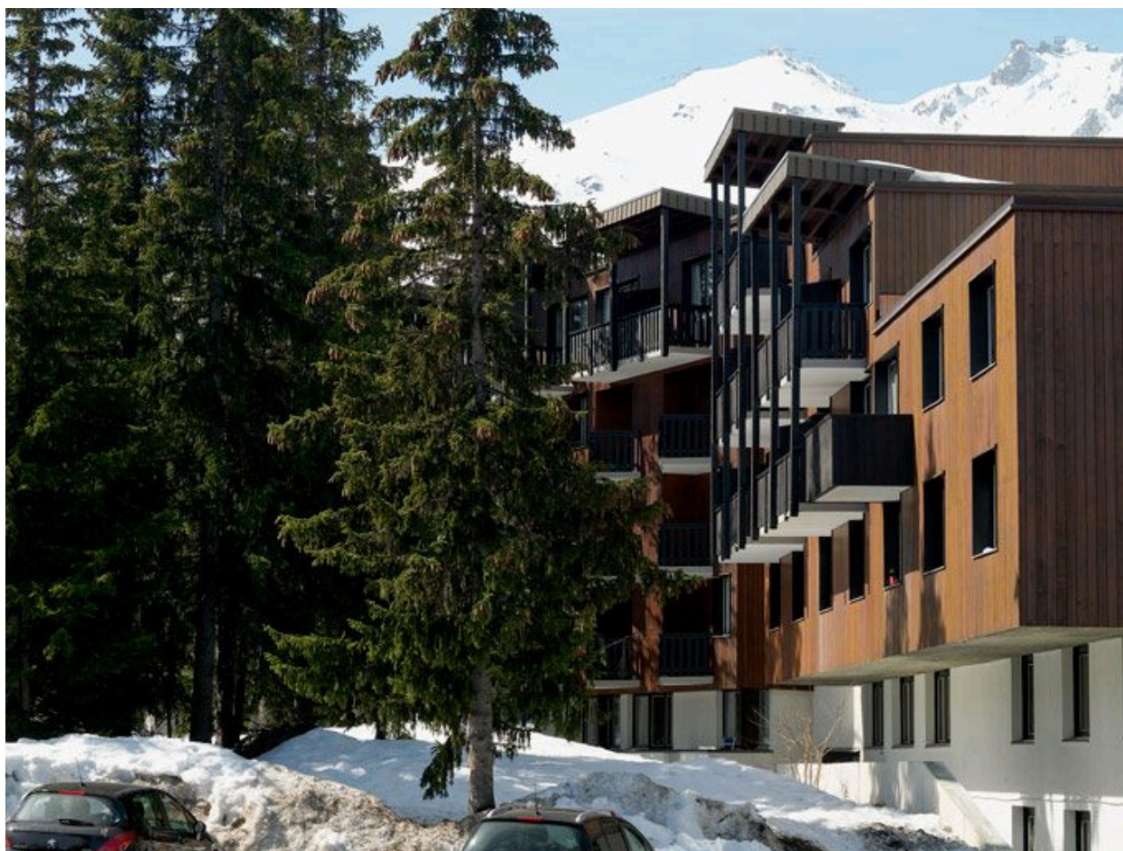
Elévation nord-est de l'hôtel Mercure
