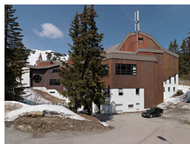
L'auditorium depuis le nord Phot. Eric Dessert IVR82_20107303748NUCA
