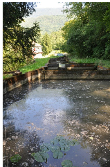
Réserve d'eau du moulin transformée pour l'activité piscicole Phot. Yannick Milleret IVR82_20107300676NUCA
