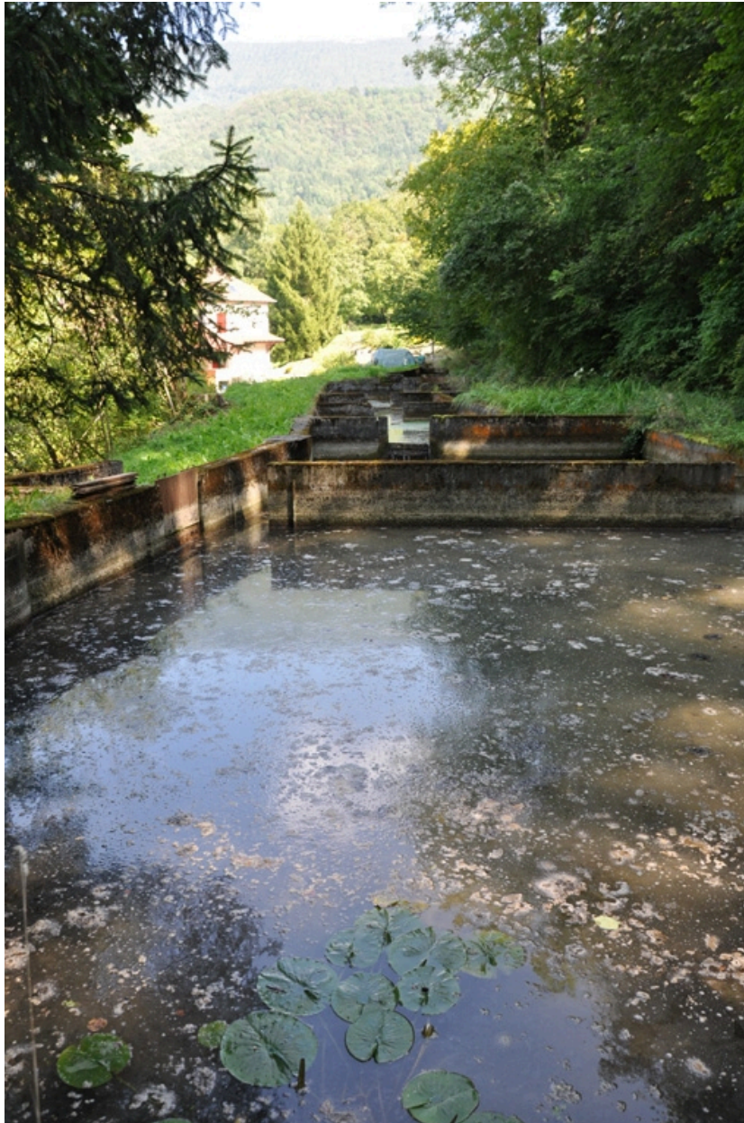
Réserve d'eau du moulin transformée pour l'activité piscicole
