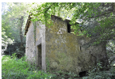
Vue générale, façades est et nord Phot. Yannick Milleret IVR82_20107300675NUCA
