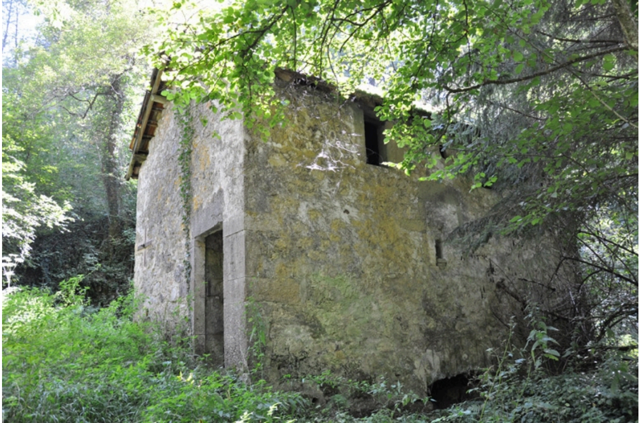
Vue générale, façades est et nord
