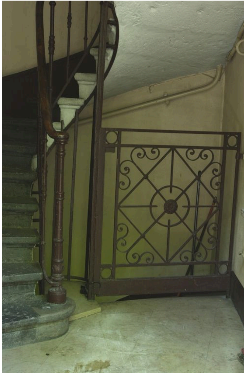
Accès à la cave : grille d'entrée
