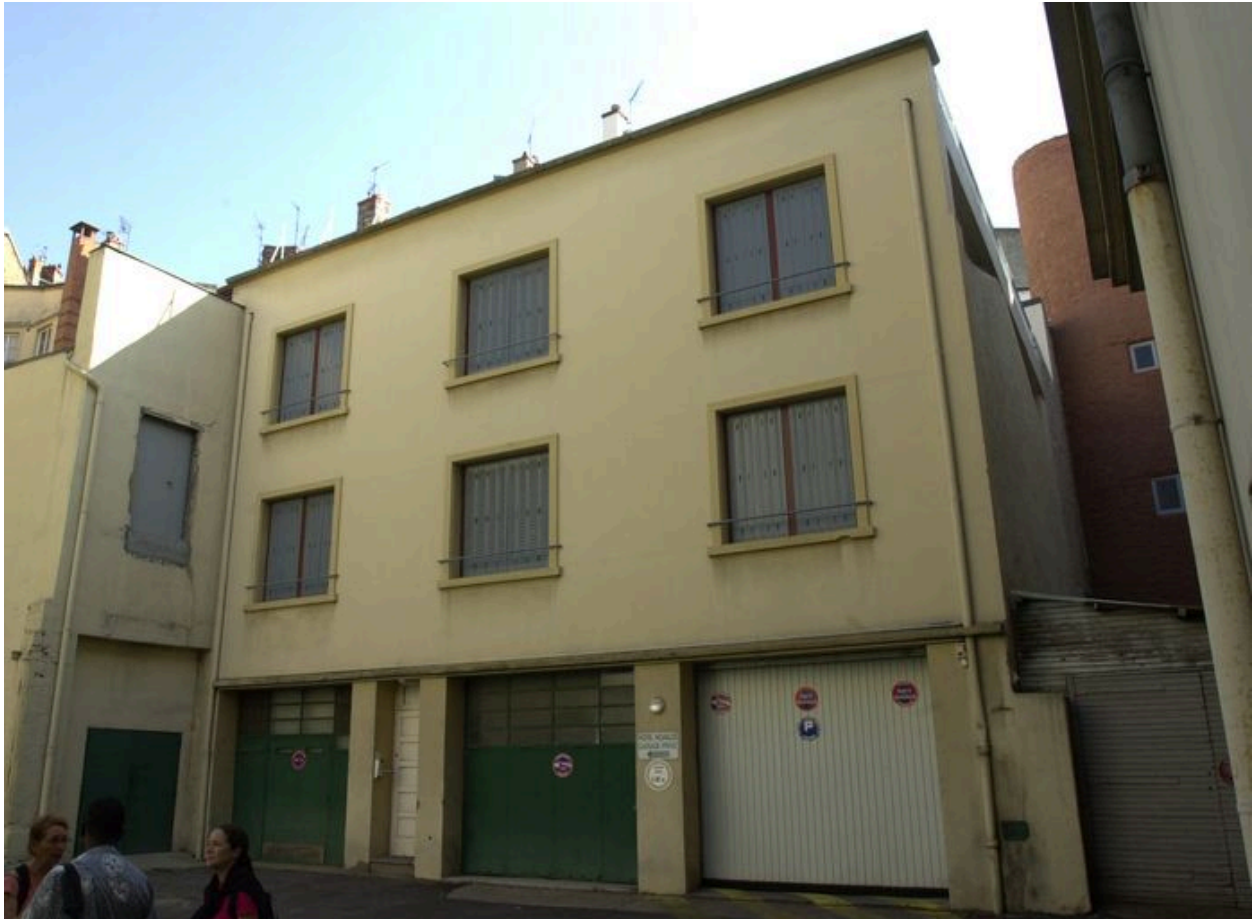
Façade postérieure de l'hôtel
