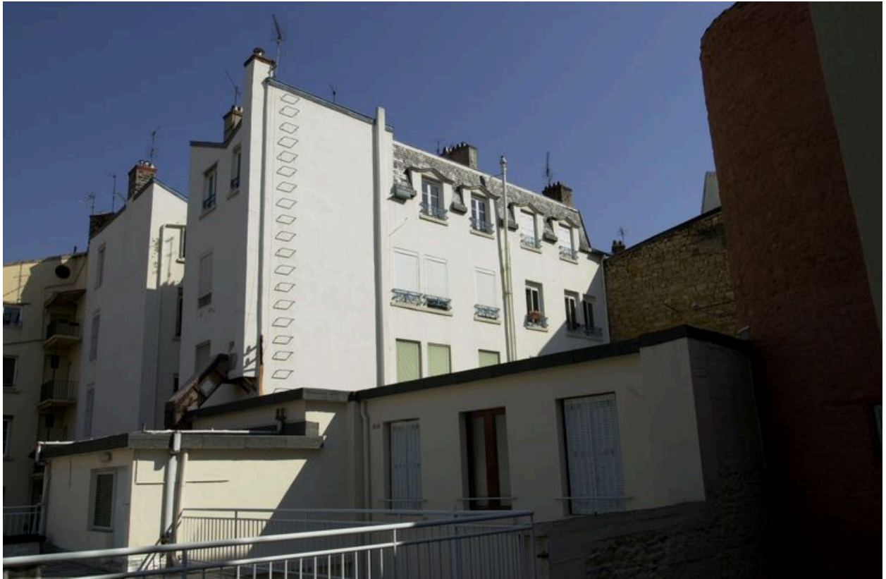
Vue générale de la façade postérieure de l'immeuble
