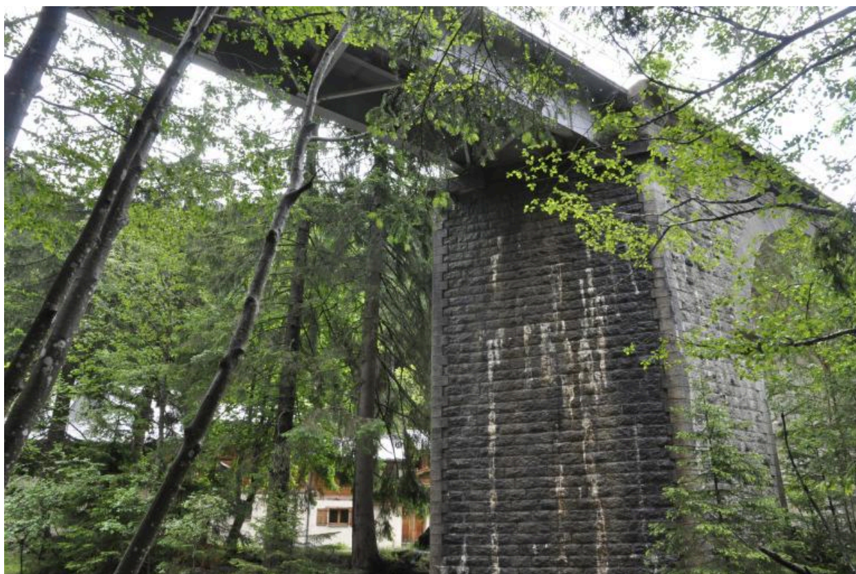
Vue de la travée centrale du viaduc des Tines prise depuis la rive droite de l'Arve
