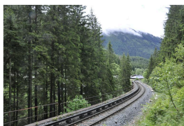
Voie ferrée en sortie sud-ouest du tunnel des Tines allant en direction du viaduc Phot. Samir Mahfoudi IVR84_20207401189NUCA
