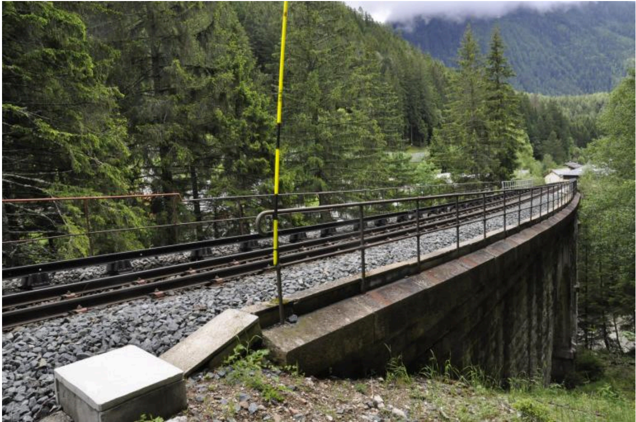
Détail de la voie ferrée et des plinthes maçonnées couvrant la face aval du viaduc
