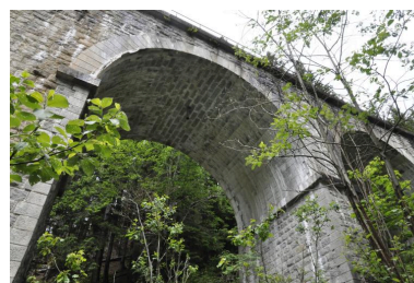
Deux cintres maçonnés supportant de nouveau la voie ferrée en rive gauche de l'Arve Phot. Samir Mahfoudi IVR84_20207401187NUCA
