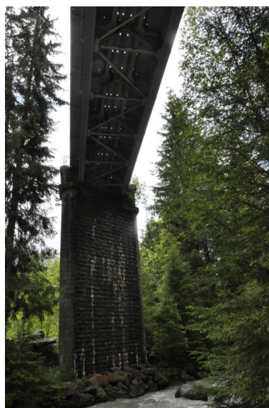
Tablier central est, en acier composé de deux poutres à âme pleines Phot. Samir Mahfoudi IVR84_20207401186NUCA
