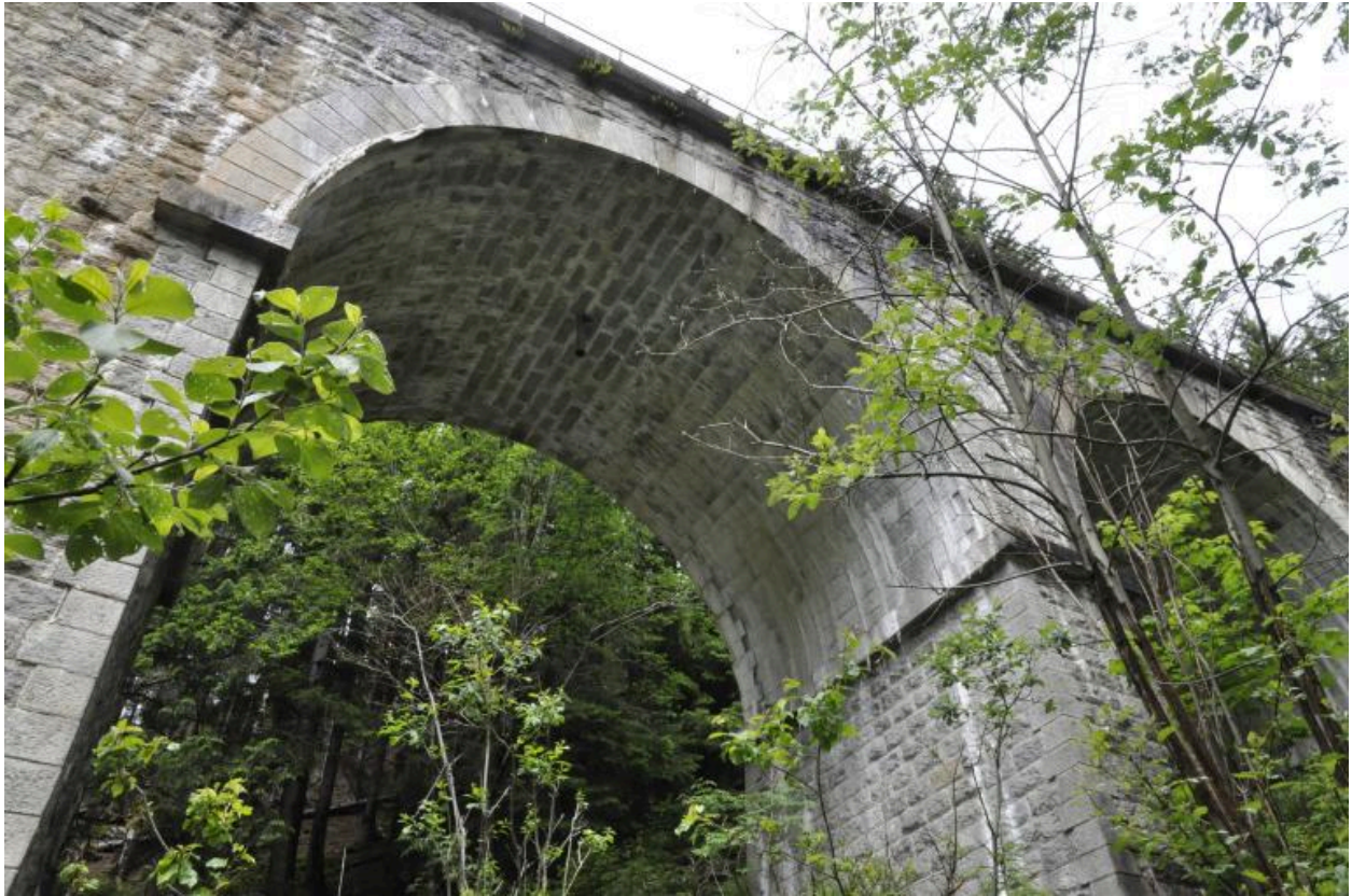
Deux cintres maçonnés supportant de nouveau la voie ferrée en rive gauche de l'Arve
