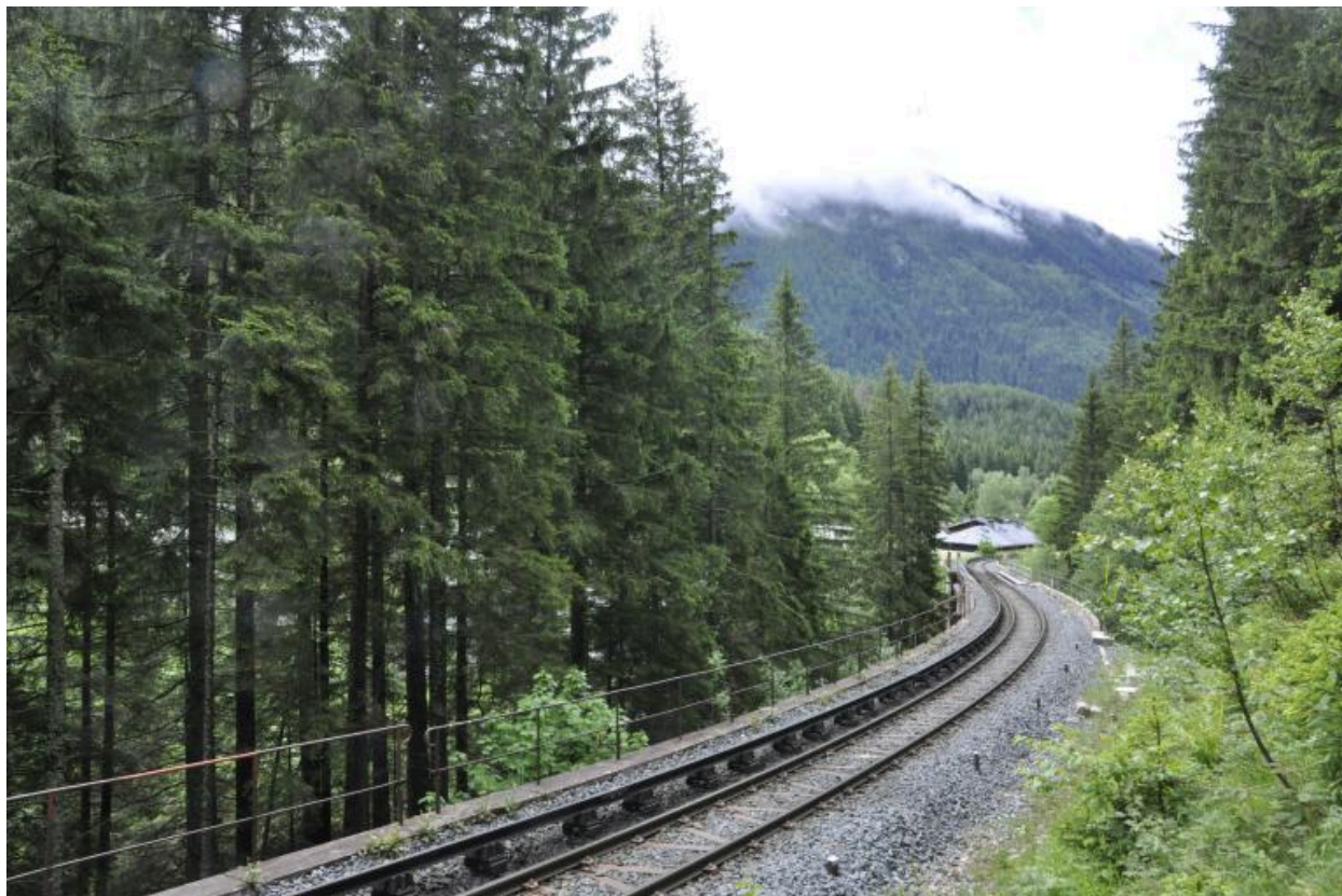
Voie ferrée en sortie sud-ouest du tunnel des Tines allant en direction du viaduc
