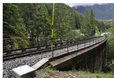
Détail de la voie ferrée et des plinthes maçonnées couronnant la face aval du viaduc Phot. Samir Mahfoudi IVR84_20207401190NUCA
