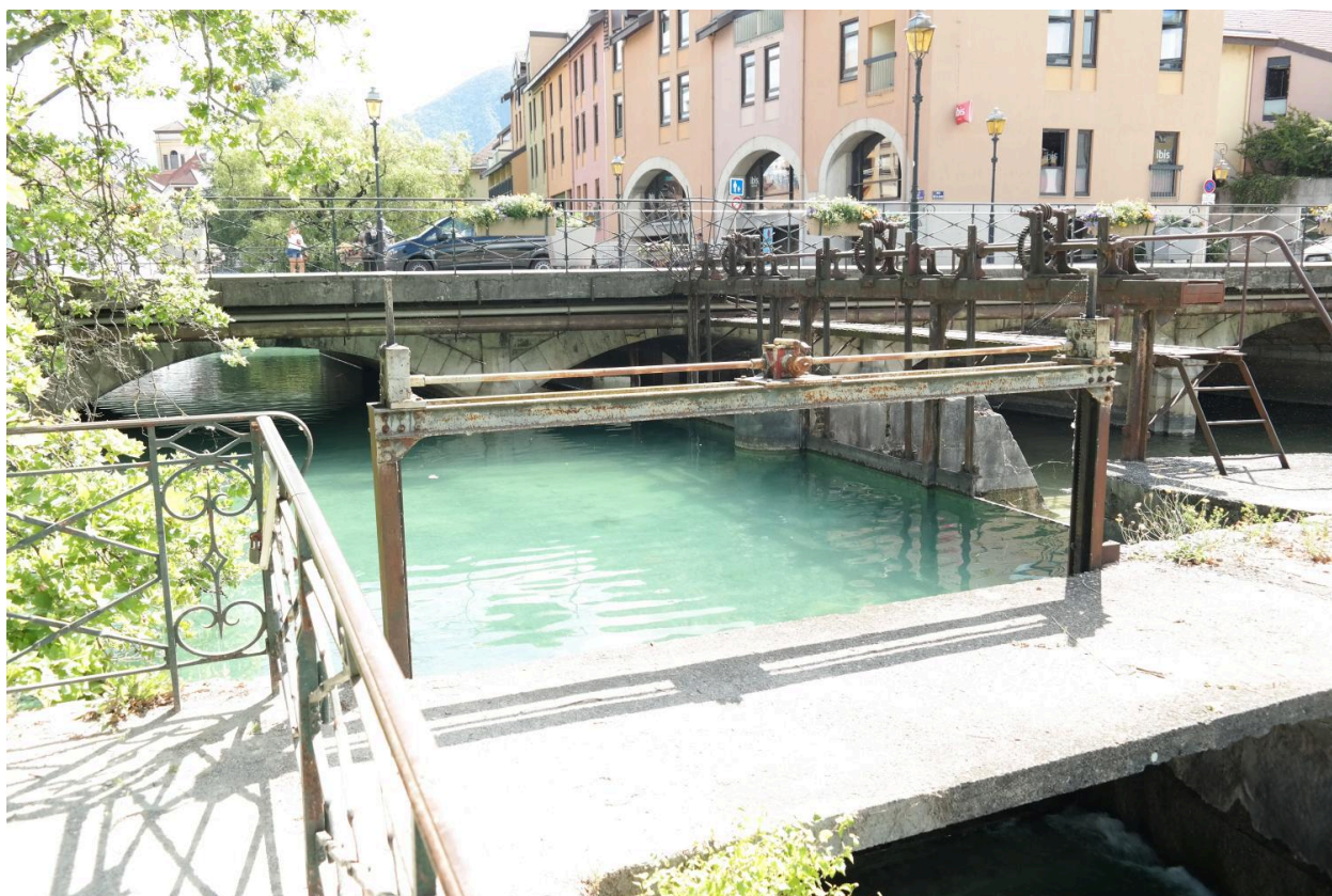
Pont rue de la gare, vue de la face aval
