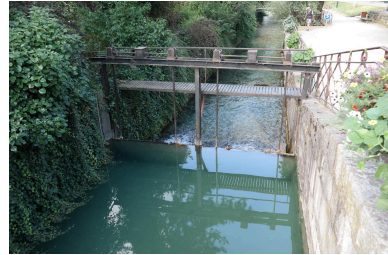
Une écluse du canal du Thiou sur l'île Saint-Joseph Phot. Pascale Renard IVR84_20207403827NUCA
