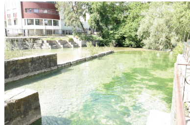
Thiou et quai de la promenade Saint-Sépulcre en aval du Pont rue de la gare Phot. Pascale Renard IVR84_20207403830NUCA
