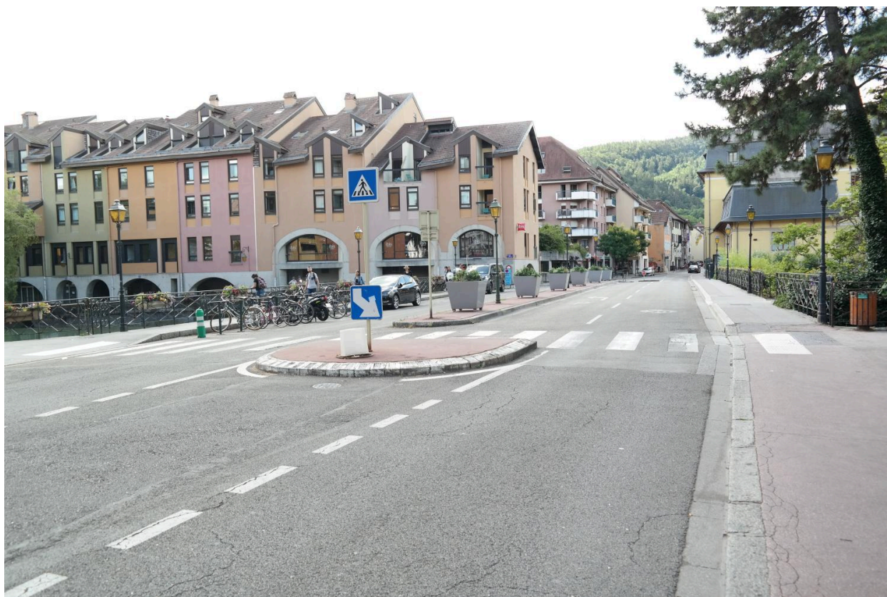
Pont rue de la gare, vue de la chaussée
