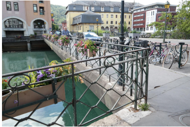
Pont rue de la gare, détail des garde-corps Phot. Pascale Renard IVR84_20207403825NUCA
