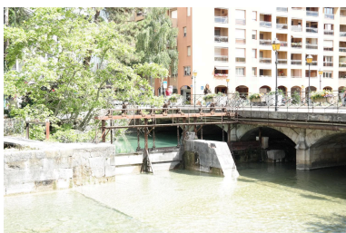
Pont rue de la gare, vue de la face aval et aménagements hydrauliques sur le Thiou Phot. Pascale Renard IVR84_20207403831NUCA
