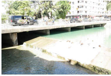
Pont rue de la gare, détail du tablier face amont Phot. Pascale Renard IVR84_20207403823NUCA
