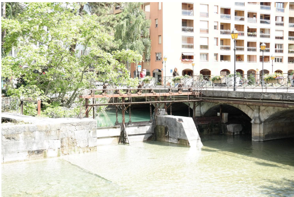
Pont rue de la gare, vue de la face aval et aménagements hydrauliques sur le Thiou
