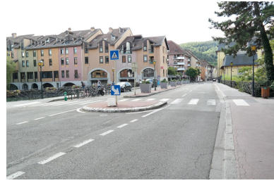
Pont rue de la gare, vue de la chaussée Phot. Pascale Renard IVR84_20207403824NUCA
