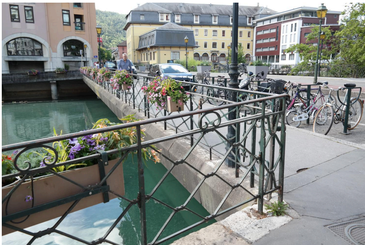
Pont rue de la gare, détail des garde-corps
