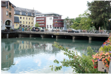
Pont rue de la gare, vue de la face amont Phot. Pascale Renard IVR84_20207403822NUCA
