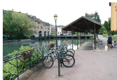
Pont rue de la gare, vue générale Phot. Pascale Renard IVR84_20207403821NUCA
