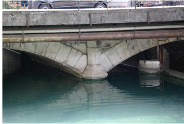
Pont rue de la gare, détail des voûtes en face aval Phot. Pascale Renard IVR84_20207403826NUCA
