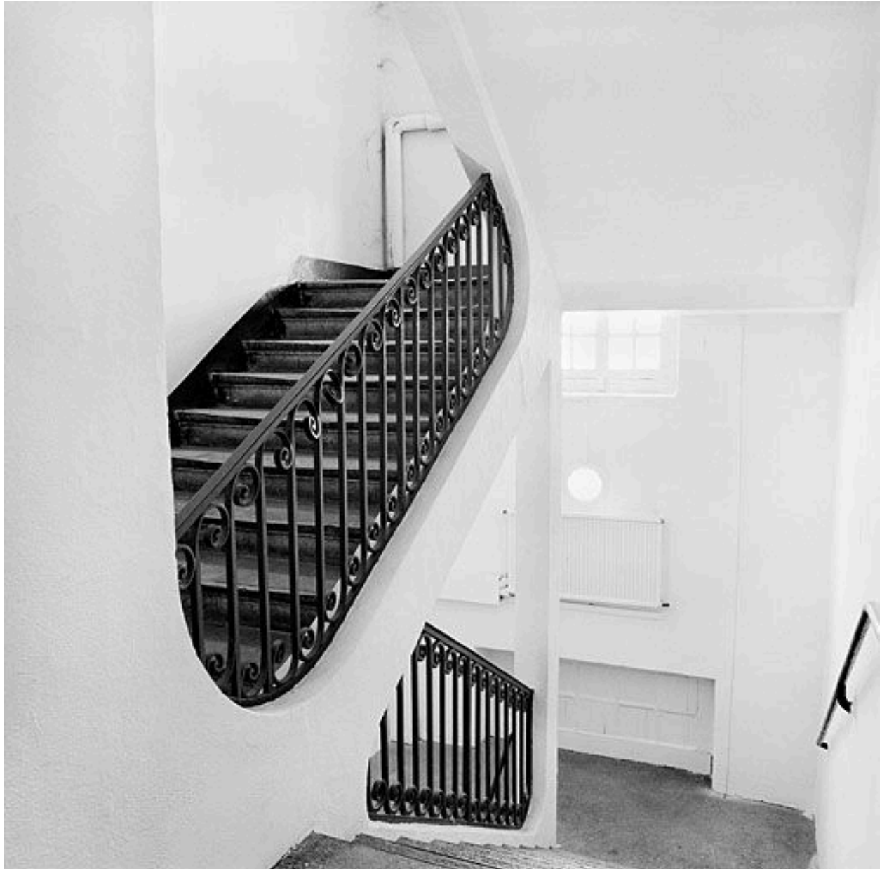
Vue du départ de l'escalier de l'extrémité nord
