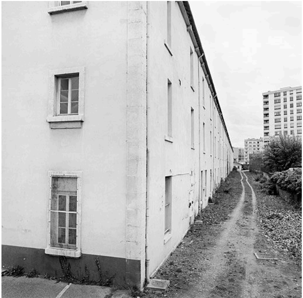
Grande caserne : élévation postérieure
